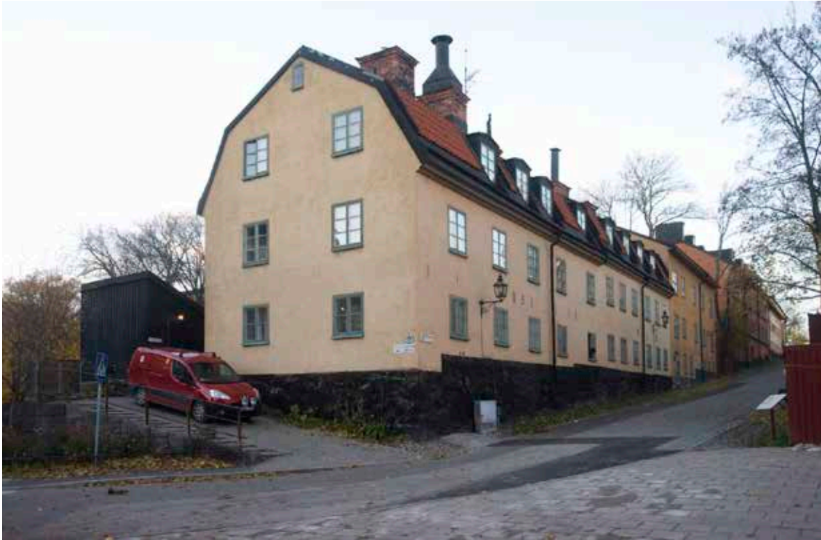
YTTERSTA TVÄRGRÄND 10 MED SITT BRUTNA TAK, SINA SLÄTPUTSADE MURAR OCH FÖNSTER PLACERADE I MURLIVET. FOTO J. MALMBERG.
