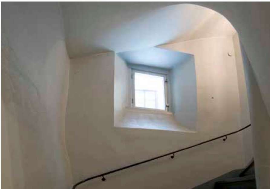
TRAPPORNA ÄR AV BETONG MED STENKLÄDDA STEG. HÄNDELEDAREN OCH FÖNSTRET PRÄGLAS AV SAMMA OMBYGGNAD, SOM SKEDDE 1942. FOTO: J. MALMBERG.
