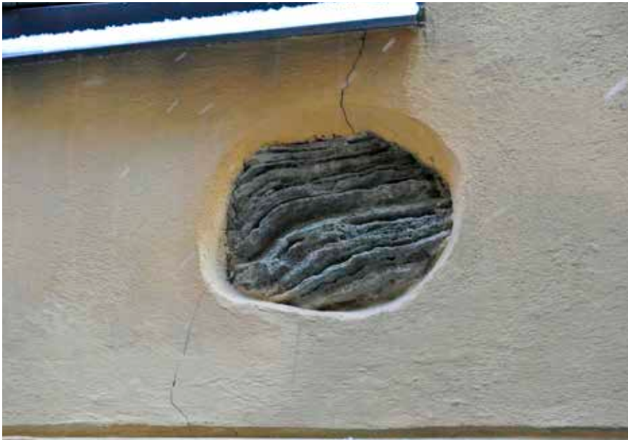
DETALJ AV ETT AV DE UTSPARADE PARTIERNÄ I FASADEN. DET SER UT SOM RÄFFLAD STEN. FOTO: J. MALMBERG.
