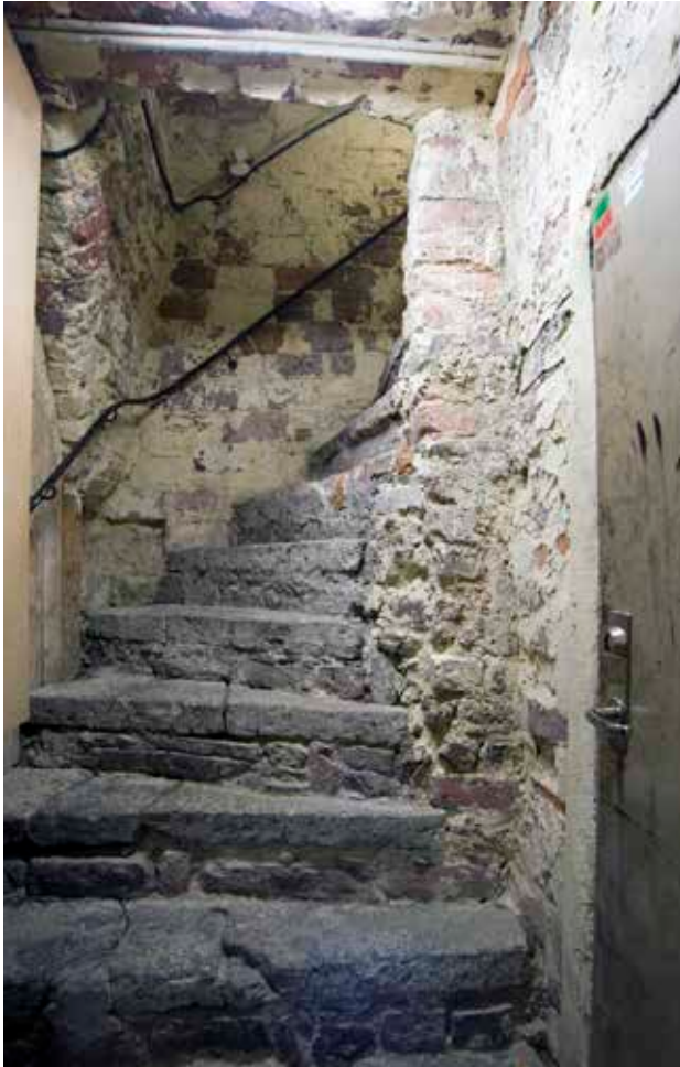
DEN ENDA ÄLDRE TRAPPAN SOM BEVARATS ÄR DEN FRÅN PORTGÅNGEN TILL KÄLLARNA. FOTO: J. MALMBERG.
