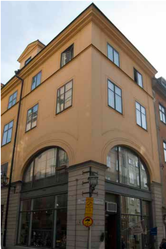
SEDAN OMBYGGNADEN 1907-1909 ÄR BOTTENVÅNINGEN RUSTICERAD OCH MED STORA, RUNDBÄGIGA FÖNSTER. FOTO: J. MALMBERG.
