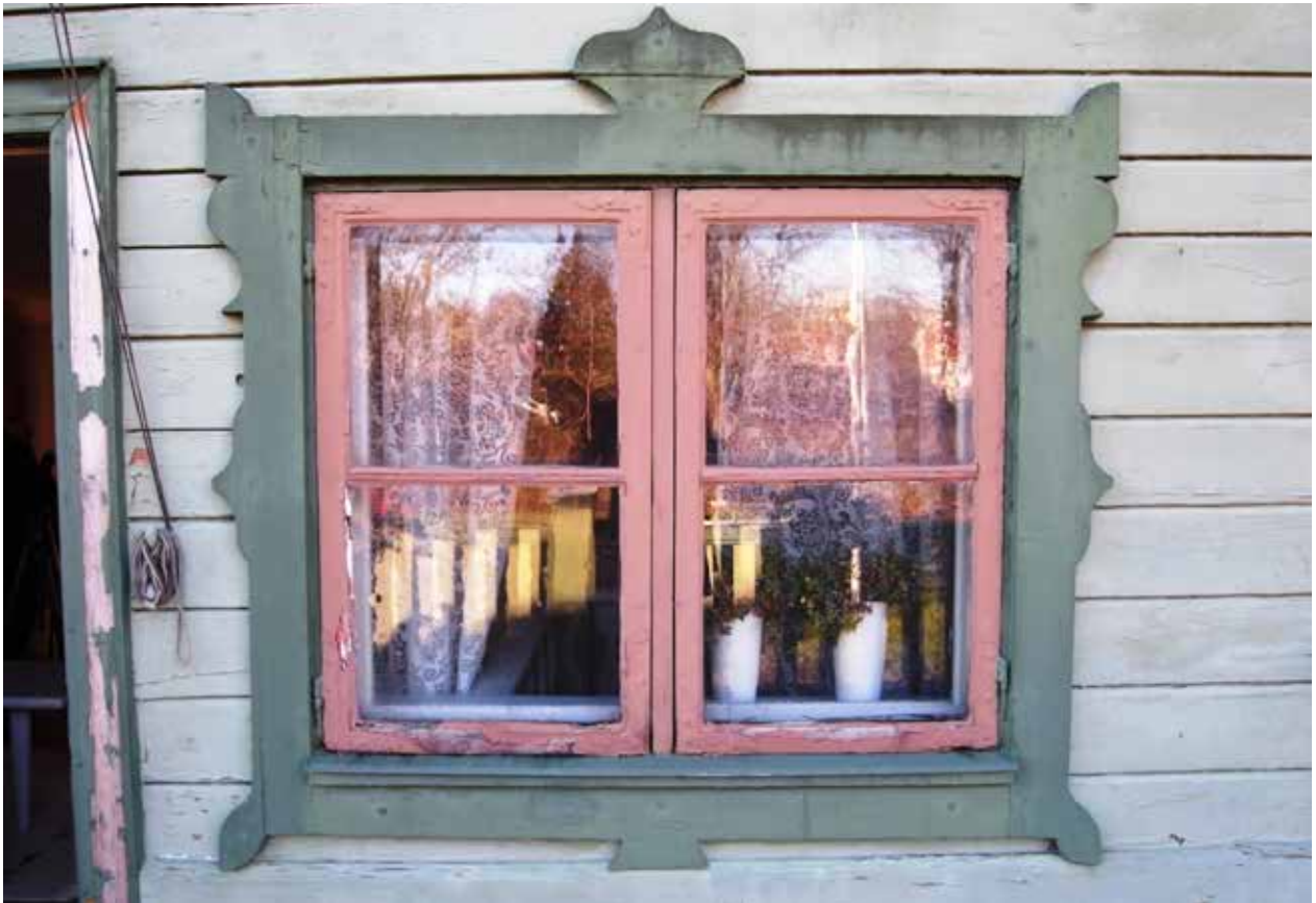
FÖNSTER PÅ HUVUDBYGGNADENS GÅRDSSIDA. HÖRNBESLAG OCH GÅNGJÄRN FRÅN 1700-TALET, KONTURSÅGAT FÖNSTERFODER FRÅN SENT 1800-TAL. FOTO B. NORDENMARK.
