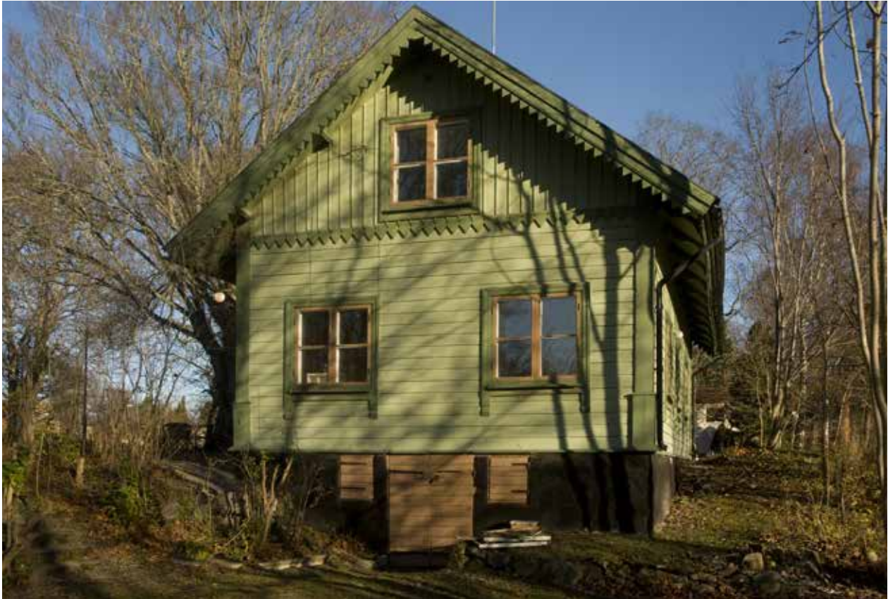
SÖDRA FLYGELNS GAVEL MED DÖRRAR OCH LUCKOR FRÅN BYGGNADSTIDEN. PANELEN ÄR LIGGANDE I NEDRE DELEN OCH STÅENDE I DEN ÖVRE OCH SATTES UPP I SLUTET AV 1800-TALET LIKSOM DE SÅGTANDADE LISTERNA. FOTO J. MALMBERG
