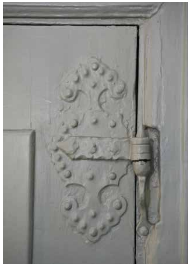
SÅ KALLADE PEPPARKAKSGÅNGJÄRN, SANNOLIKT FRÅN SLUTET AV 1600-TALET, PÅ EN AV DÖRRARNA I HUVUDBYGGNADEN. FOTO J. MALMBERG.
