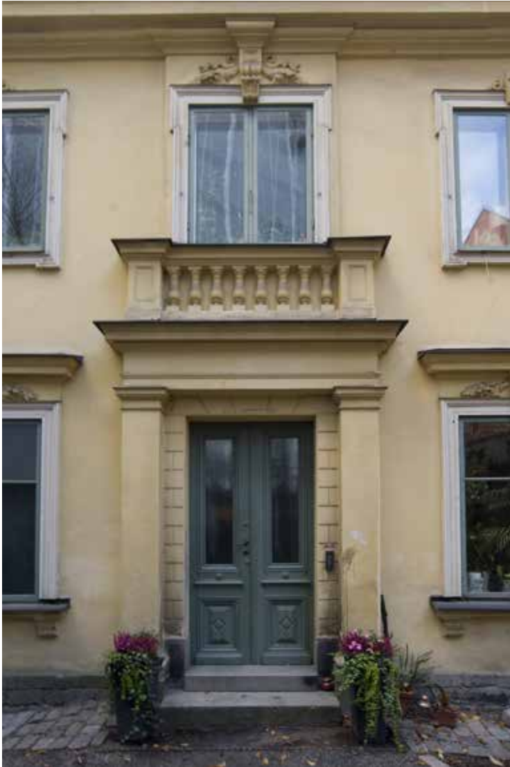
HUVUDENTRÉN MED GLASAD, HELFRANSK PARDÖRR, PELARE OCH OVANFÖRSITTANDE BALUSTRAD FRÅN RENOVERINGEN ÅR 1875. FOTO. J MALMBERG.
