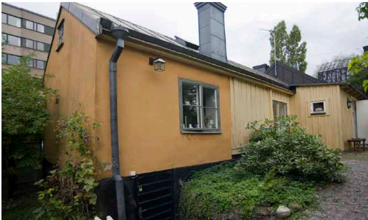
HUSEN VID NR 6A FRÅN GÄRDSSIDAN. FOTO J. MALMBERG.
