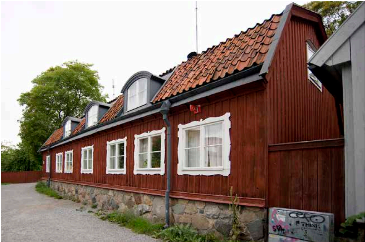
DEN RÖDA, PANELKLÄDDA TIMMERLÄNGAN VID GAMLA LUNDAGATAN 12. HUSET UPPFÖRDES TROLIGEN I MITTEN AV 1700-TALET MEN HAR SENARE BYGGTS TILL. FOTO J. MALMBERG.
