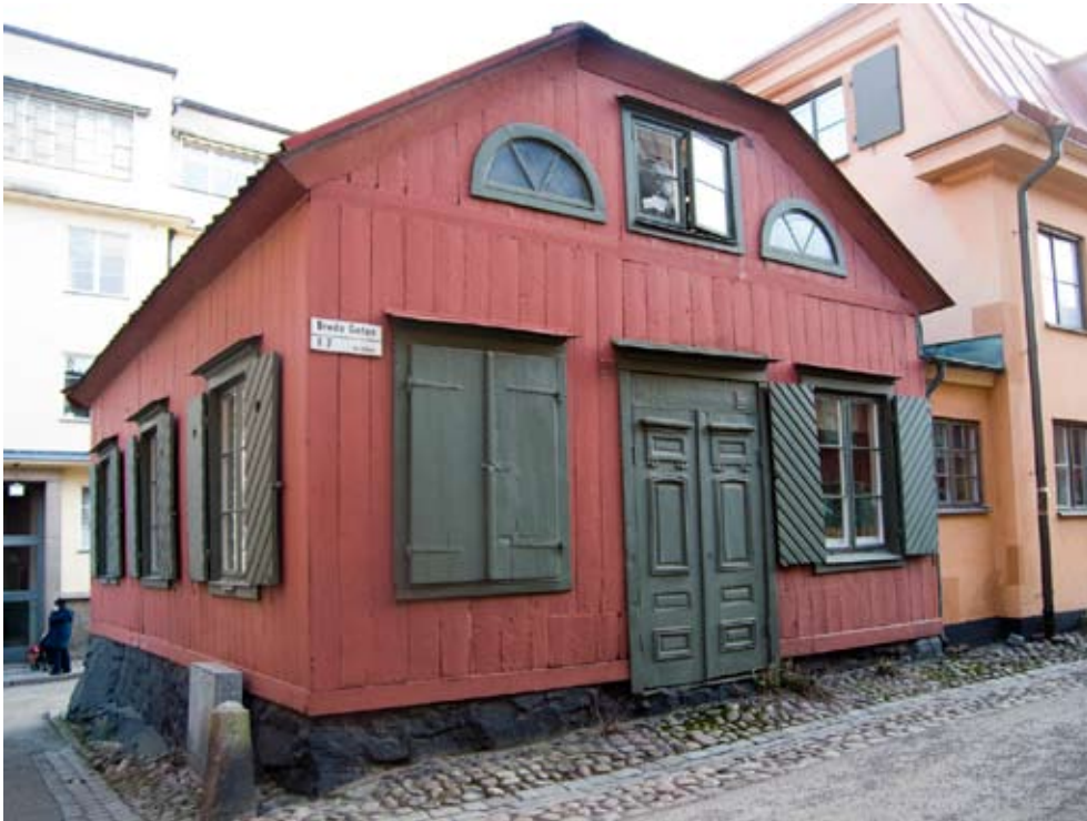
DÖRRBLADEN I PARDÖRREN MOT BREDA GATAN HAR VID EN RENOVERING PÅ 1940-TALET VÄNTS SÅ ATT DEN DEKORATIVA SIDAN SYNS UTIFRÅN. FOTO: J. MALMBERG.
