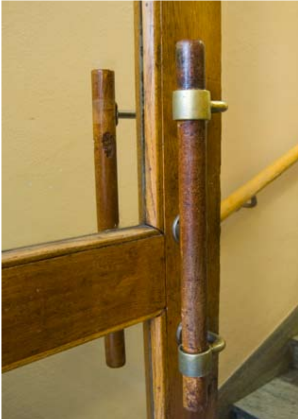
DETALJ AV ENTRÉDÖRR. FOTO: J. MALMBERG.
