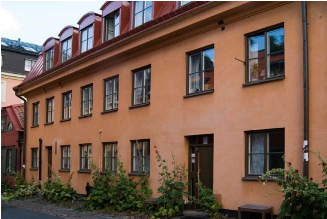
FASAD MOT BREDA GATAN. FOTO: J. MALMBERG.
