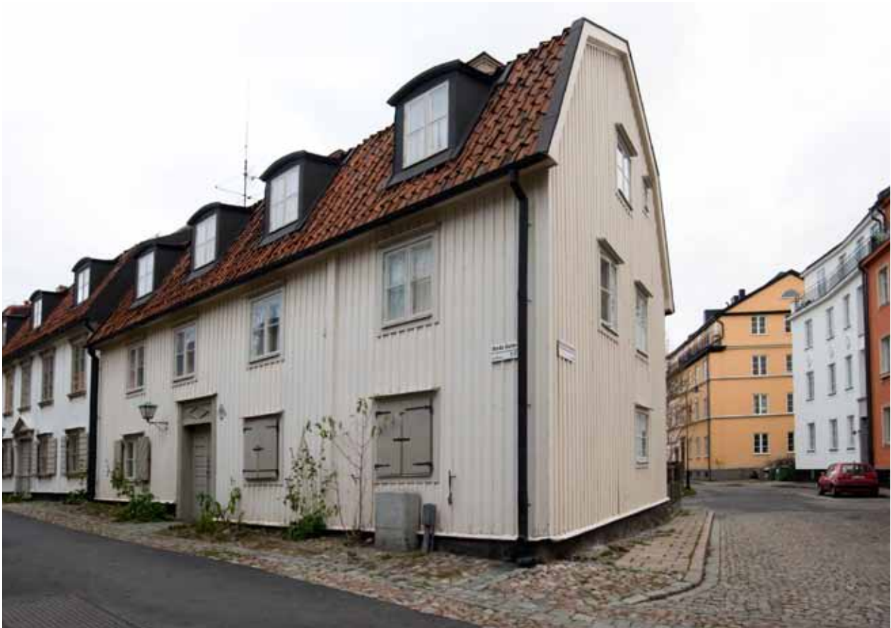
FASAD MOT BREDA GATAN. FOTO. J MALMBERG.
