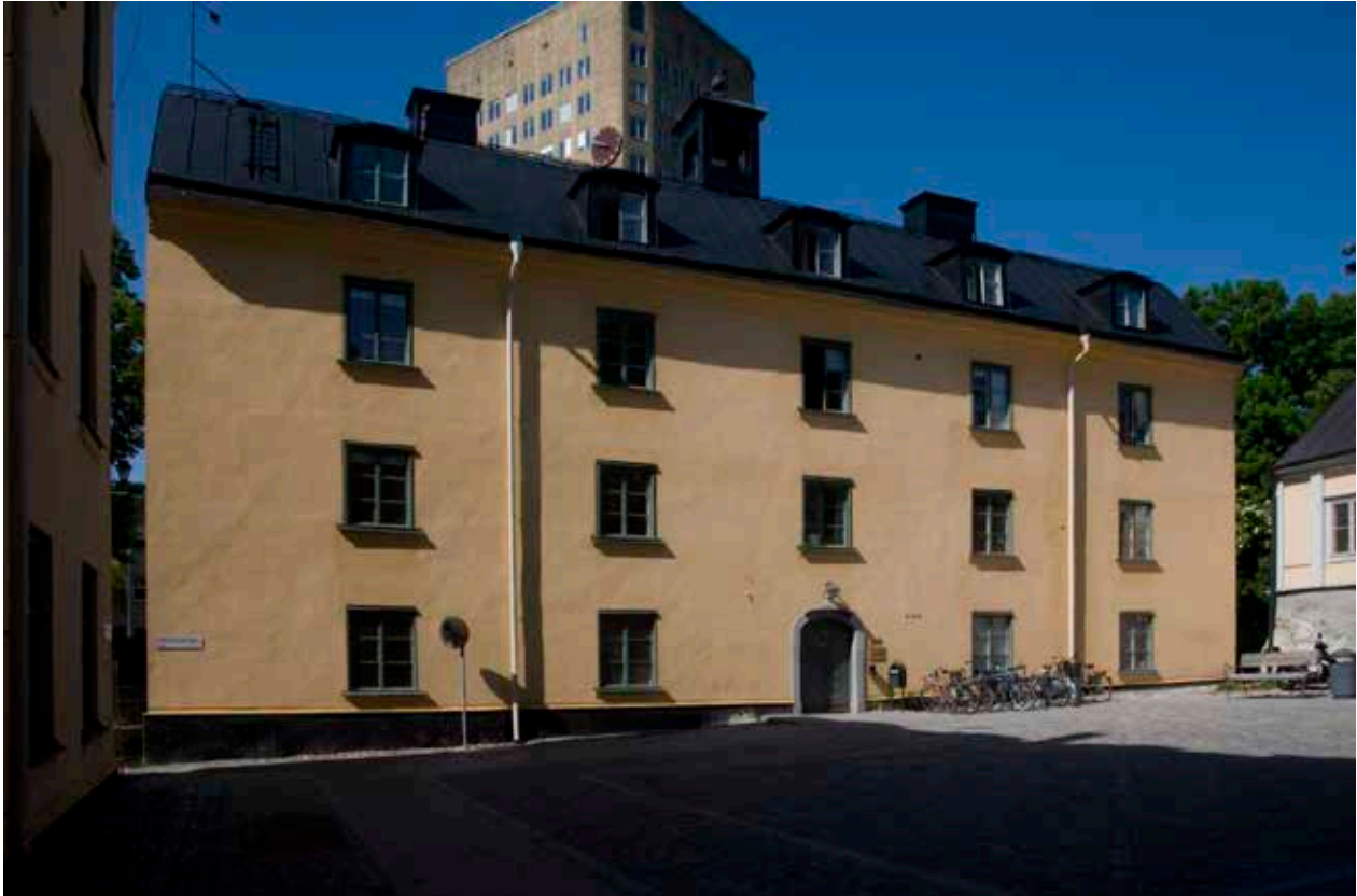
NICOLAIHUSETS HUVUDFASAD MED SIN VÄLBEHÅLLNA 1700-TALSKARAKTÄR. PÅ TAKET SKYMTAR DET LILLA KLOCKTORNET FRÅN BYGGNADSTIDEN. FOTO J. MALMBERG.
