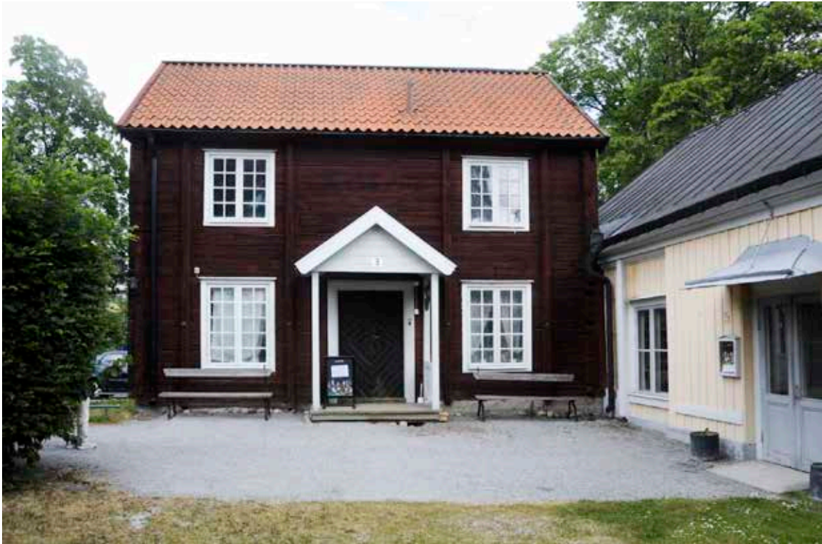
DET TIMRADE HUSET, LOFTBODEN, FRÅN OMKRING 1730. FARSTUKVISTEN ÄR RELATIVT NYGJORD MEN EFTERLIKAR EN ÄLDRE SOM HAR FUNNITS HÄR. FOTO J. MALMBERG.
