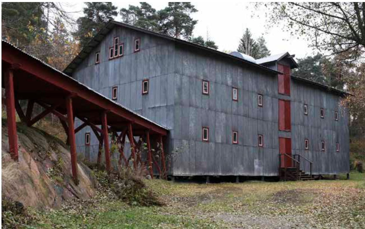
VY MOT MAGASINETS NORRA GAVEL OCH VÄSTRA LÅNGSIDA. MAGASINET HAR EN URSPRUNGLIG INKLÄDNAD AV KORRUGERAD PLÅT, VID TIDEN EN NYMODIGHET SOM IMPORTERADES FRÅN ENGLAND. TILL VÄNSTER I BILD TRANSPORTBANDET. FOTO B. MELLSTRÖM
