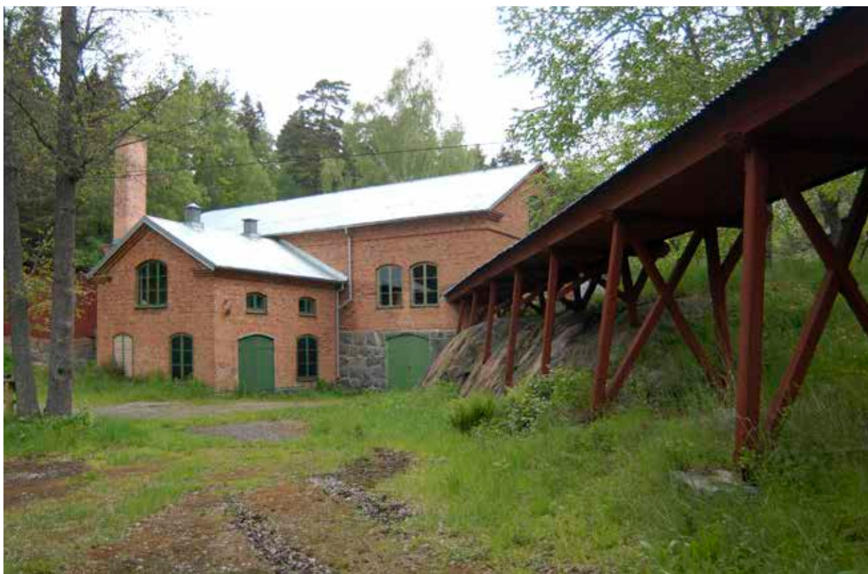
MOT KVARNBYGGNADENS SYDSIDA FINNS EN LÄGRE UTBYGGNAD SOM TIDIGAST INRYMDE SPANNMÅLSTORK. I DAG HAR ANVÄNDS UTBYGGNADENS BOTTENPLAN SOM CAFÉ VID DE ÅTERKOMMANDE KVARNDAGARNA, DÅ KVARNARNA DRAS IGÅNG FÖR ÖPPET HUS. TILL HÖGER I BILD TRANSPORTVER-KET MELLAN KVARNBYGGNADEN OCH MAGASINET. FOTO B. MELLSTRÖM.
