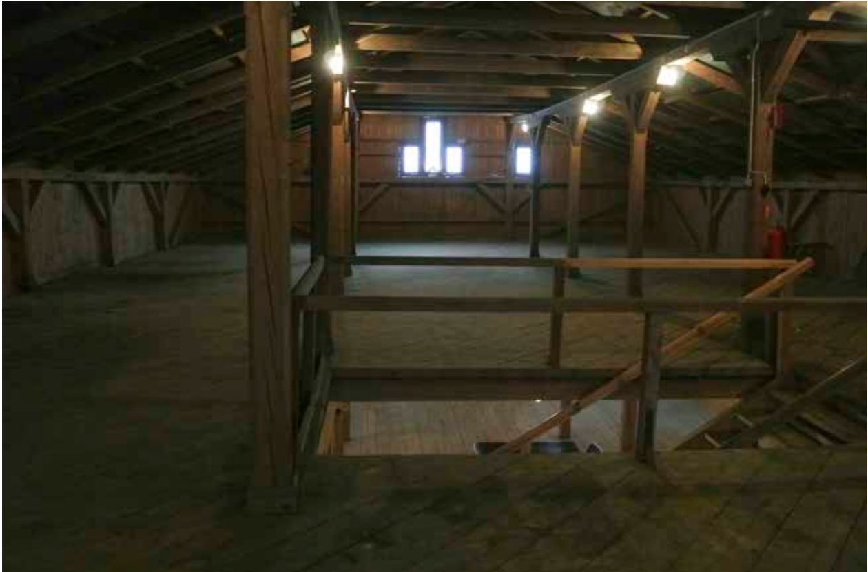
MAGASINETS INTERIÖRER ÄR STORA OCH ÖPPNA, PÅ BILDEN VINDSPANET. SPÄNNVIDDERNA BÄRS UPP AV KRAFTIGA TRÄSTOLPAR MED FÖRGRENAT STÖD MOT BJÄLKLAGEN. FOTO J. MALMBERG.
