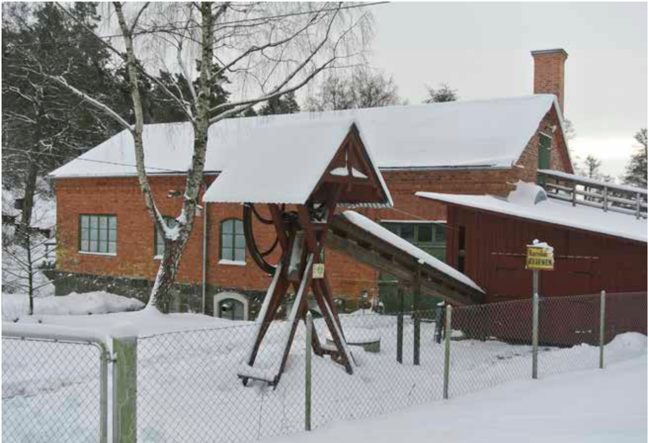
VY MOT KVARNBYGGNADENS NORRSIDA MED DET ANSLUTANDE SÅGHUSET TILL HÖGER I BILD. I FÖRGRUNDEN SPÅNELEVATORN. FOTO J. MALMBERG.
