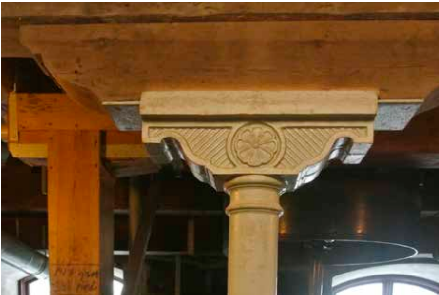
DETALJBILD AV KÄLLARPLANETS GJUTJÄRNSKOLONNER MED DEKORATIVT UTFORMADE KAPITÄL. FOTO J. MALMBERG.
