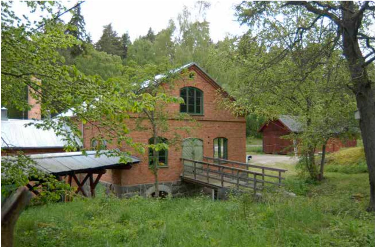
VY MOT KVARNBYGGNADENS ÖSTRA GAVEL MED KÖRBRON IN TILL KVARNRUMMET. TILL VÄNSTER I BILD SKYMTAR TRANSPORTVERKET MELLAN KVARNBYGGNADEN OCH MAGASINET OCH LÄNGRE BORT TILL HÖGER I BILD SYNS TORKLADAN FÖR VIRKET. FOTO B. MELLSTRÖM.
