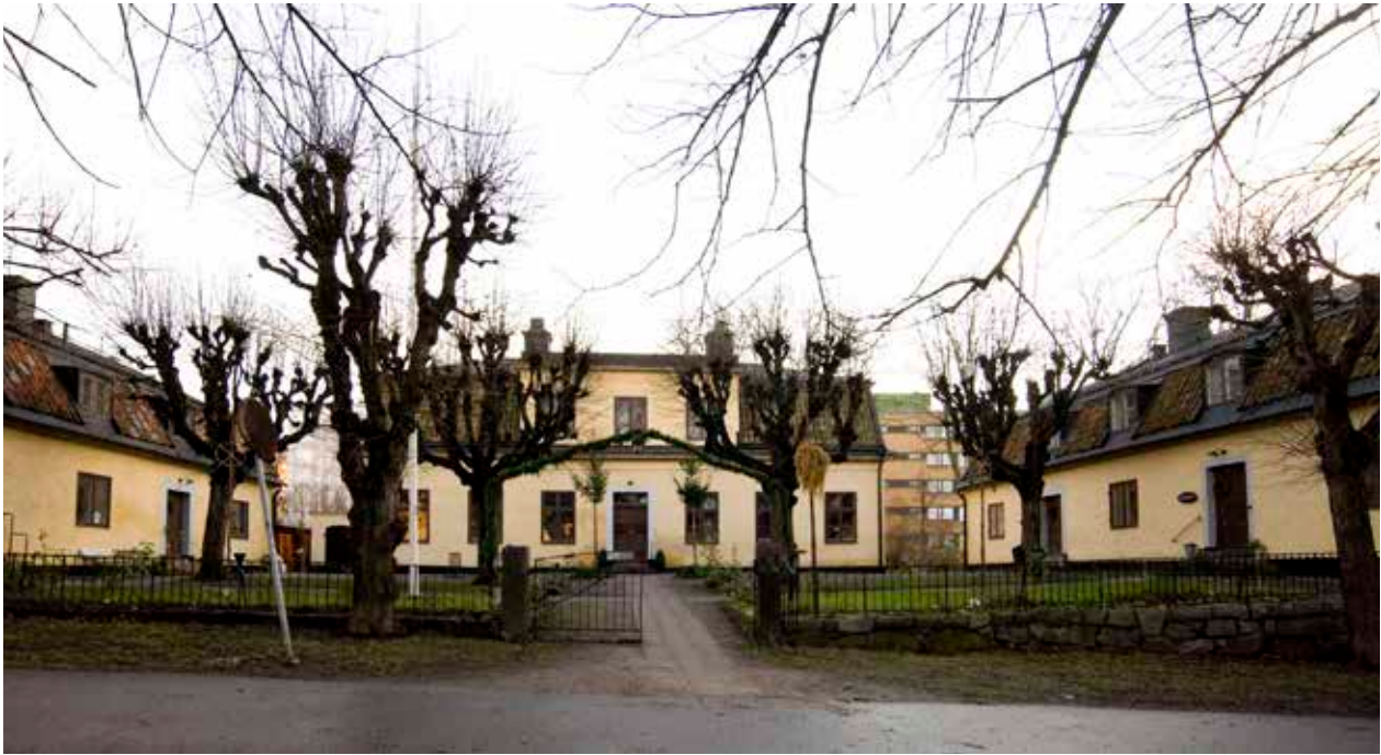
HUVUDBYGGNADEN MED ÖSTRA OCH VÄSTRA FLYGELN SEDDA FRÅN NORR. MELLAN BYGGNADERNA LIGGER TRÄDGÅRDEN MED SINA KARAKTERISTISKA LINDAR. FOTO J. MALMBERG.
