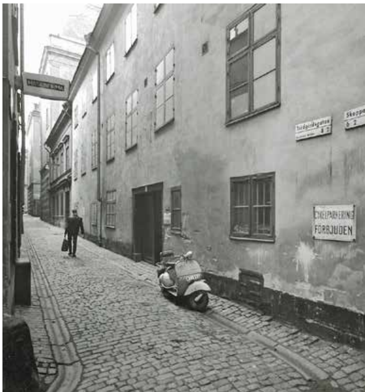
VY VÄSTERUT LÄNGS TRÄDGÅRDSGATAN FÖRE RIVNINGARNA FÖR BOLLHUSTÄPPAN. DEN GAMLA HEDERSKÖLDSCA FASTIGHETEN SYNS TILL HÖGER I BILD MED PORTGÅNGEN TILL GÅRDEN STRAX BAKOM VESPAN. GÅRDSLÄNGAN VAR TVÅVÅNIG UNDER ETT BRUTET TAK, MEN MOT GATAN HADE DET NEDRE TAKFALLET ERSATTS MED FÖRHÖJD MUR SÅ ATT LÄNGAN TYCKS HA TRE FULLVÅNINGAR. MAN KAN LÄGGA MÄRKE TILL STENOMFATTNINGEN TILL DET LILLA FÖNSTRET TILL HÖGER OM FOTGÅNGAREN - SAMMA OMFATTNING BEVARAS I DAGENS FASAD TILL GÅRDSHUSET. FOTO LENNART AF PETERSENS 1959, SSM F66271.
