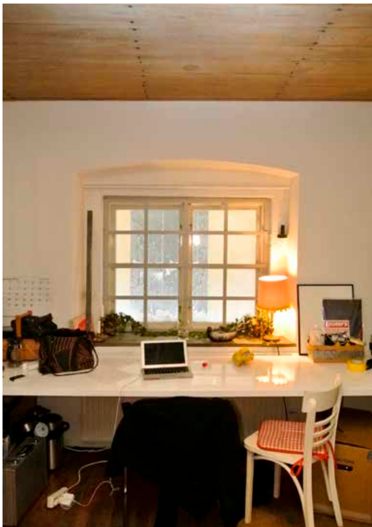
FOTO INIFRÅN HUSET MOT FÖNSTRET. TILL HÖGER I FÖNSTERNISCHEN SYNS EN KRAFTIG GÅNGJÄRNS-HAKE TILL EN PORT. HAKEN ÄR ETT TECKEN PÅ ATT ÅTMINSTONE MURARNA MOT GATAN ÄR BEVARADE FRÅN DEN RIVNA LÄNGAN, SOM I ÄLDRE TID BLAND ANNAT VAR INREDD TILL STALL MED PORT MOT GATAN. FOTO J. MALMBERG.
