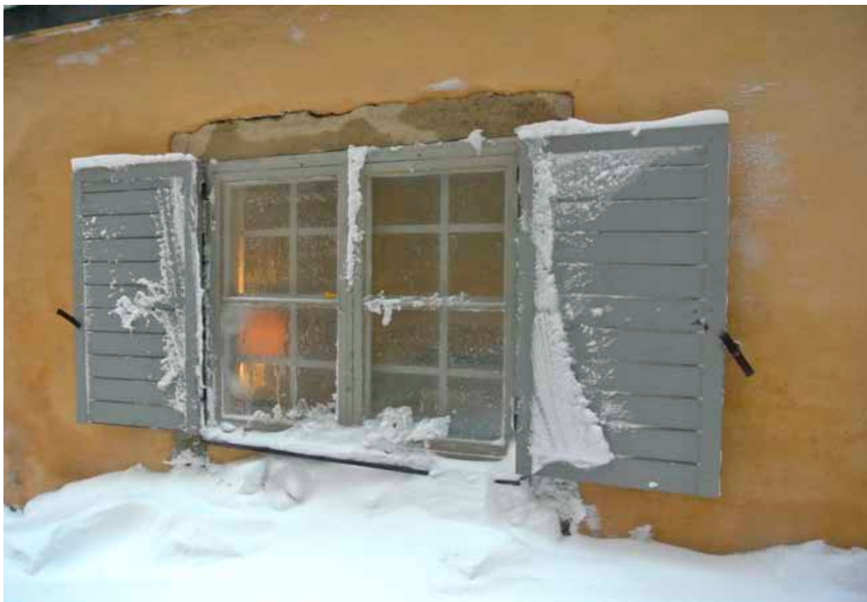
GÅRDSHUSETS ENDA FÖNSTER VETTER MOT GATAN OCH ÄR FÖRSETT MED FÖNSTERLUCKOR. DEN RIV-NA GÅRDSLÄNGAN HADE FÖNSTERLUCKOR MOT GÅRDEN. FOTO J. MALMBERG.
