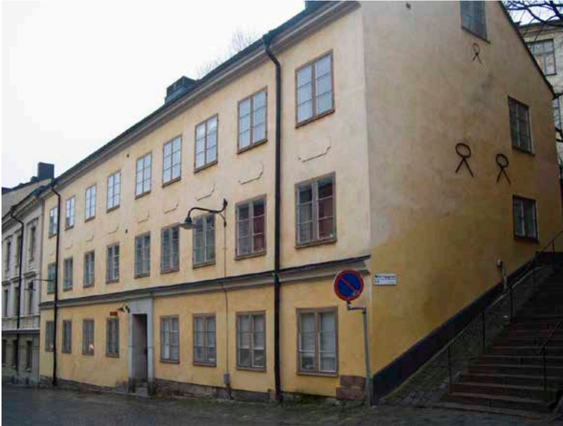
EXTERIÖR MED SLÄTPUTSAD FASAD, DEKORATIVA PUTSFÄLT MED NUPNA HÖRN SAMT ÖGLEFORMADE ANKARSLUTAR. FOTO J. MALMBERG.
