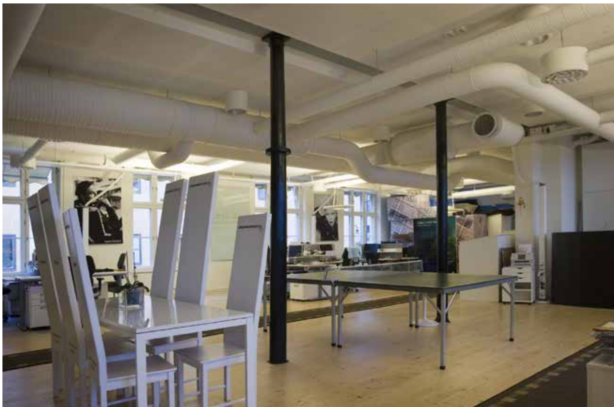
KONTORSLOKAL MED ÄLDRE GJUTJÄRNSPELARE. FOTO. J MALMBERG.
