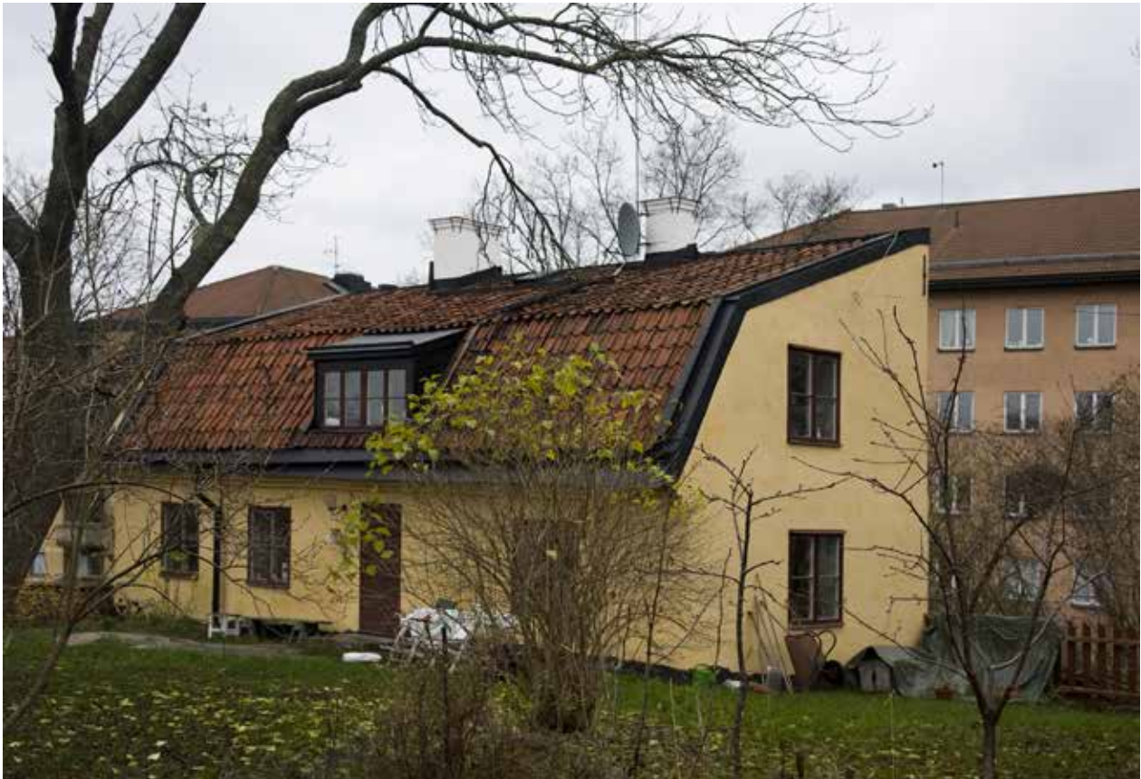
BERGSPRÄNGARGRÄND 1 SOM UPPFÖRDES UNDER 1810-TALET. FOTO: J. MALMBERG
