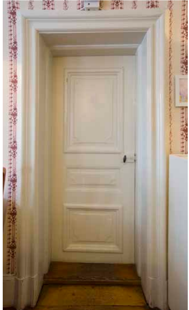
DÖRR OCH DÖRRFODER AV ROKOKOTYP FRÅN OMBYGGNADEN VID MITTEN AV 1700-TALET. FOTO J. MALMBERG.
