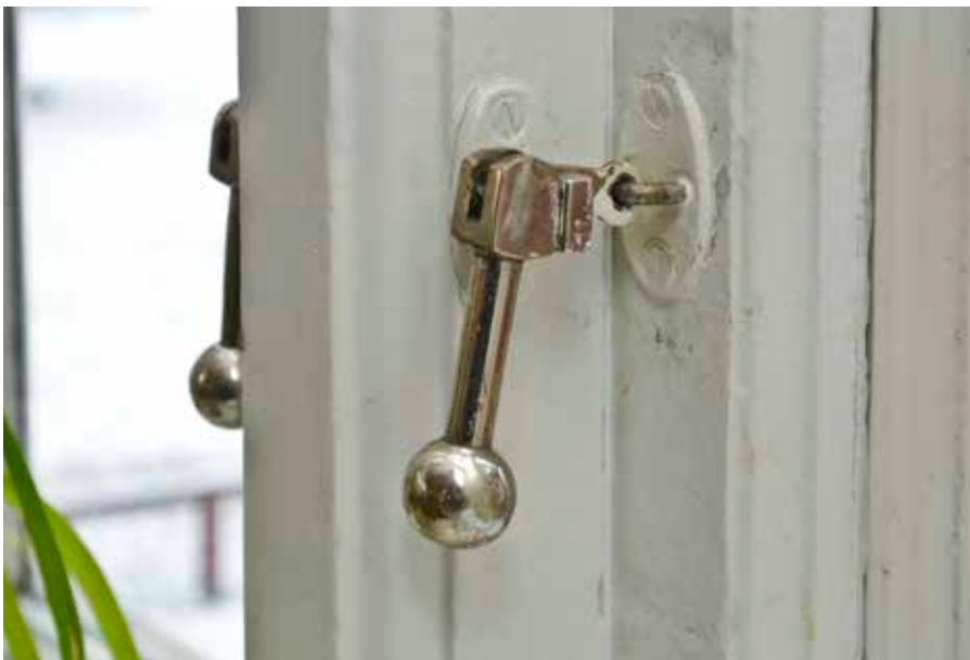
KARAKTERISTISKA FÖNSTERHASPÄR I FÖRNICKLAD MÄSSING. TROLIGTVIS FRÅN RENOVERINGEN I BÖRJAN AV 1900-TALET. FOTO J. MALMBERG.
