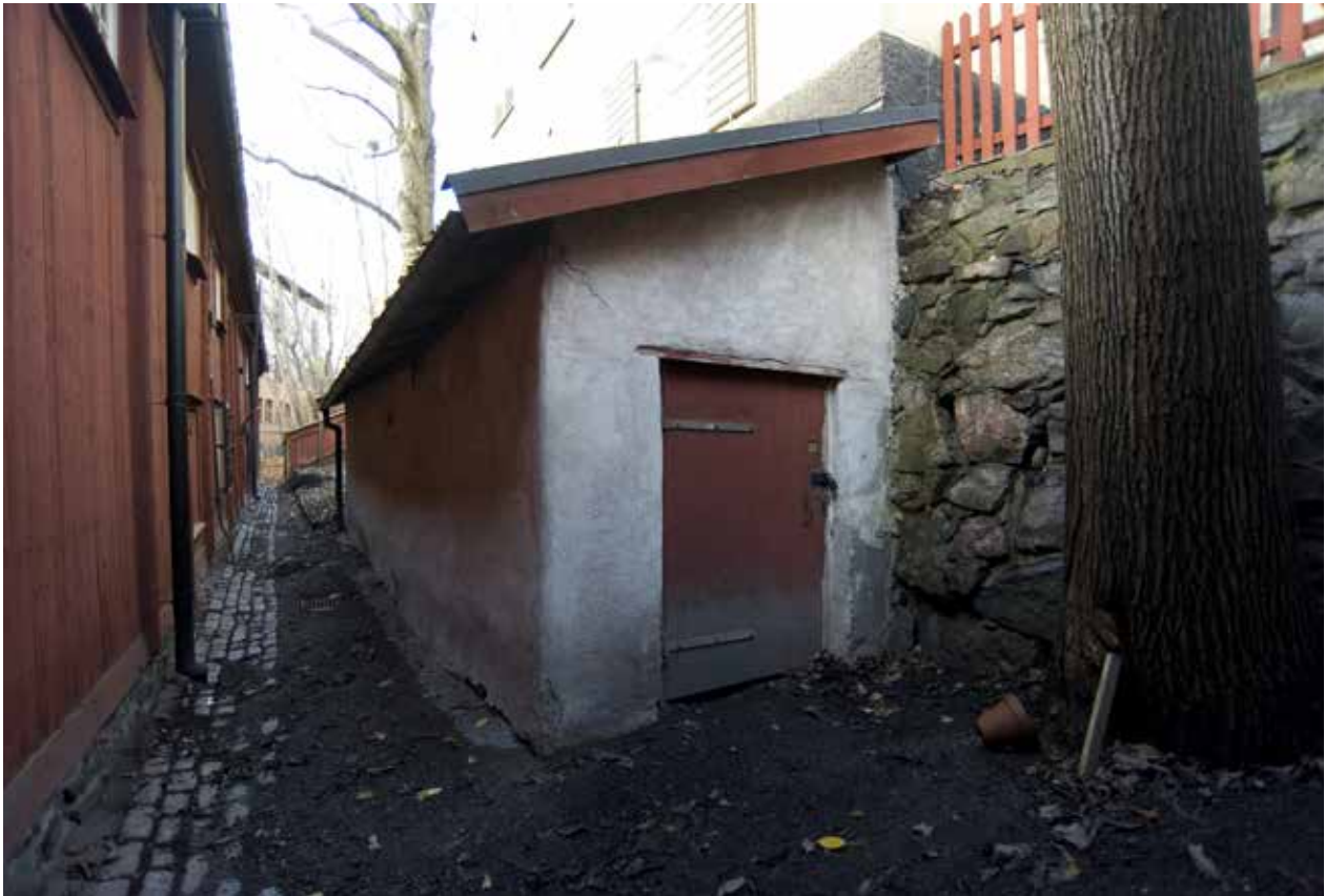
BAKSIDAN NORR OM TRÄHUSET MED STENMUR MOT DEN ÖVRE TOMTDELEN DÄR STENHUSET ÄR PLACERAT. ETT PUTSAT UTHUS LEDER TILL TVÅ VÄLVDA KÄLLARE UNDER STENHUSET. FOTO: J. MALMBERG.
