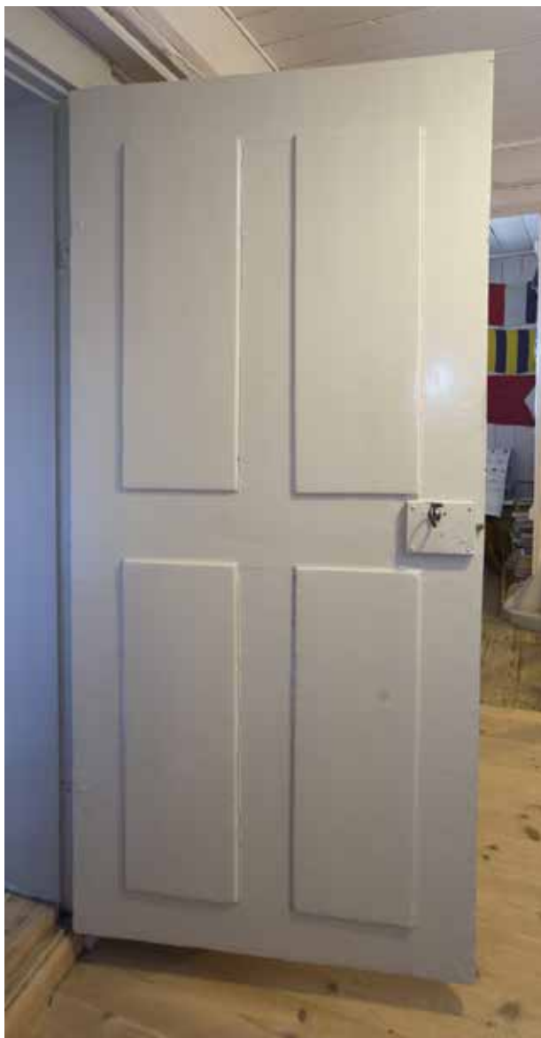
DÖRRPARTI MED FYRA UTANPÅLIGGANDE FYLLNINGAR OCH ÄLDRE KAMMARLÅS. FOTO. J MALMBERG.
