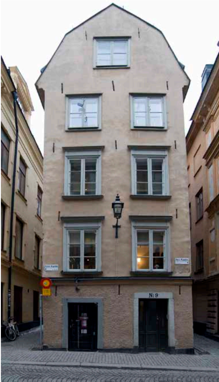
FASADEN MOT GATAN ÄR ENKEL MED OMFATTNINGAR KRING FÖNSTER OCH PORTAR. I FASADEN SITTER FLERA ANKARSLUTAR AV MEDELTIDA TYP, MEN SANNOLIKT I NYA LÄGEN SEDAN GATAN DROGS FRAM PÅ 1630-TALET. FOTO: J. MALMBERG.
