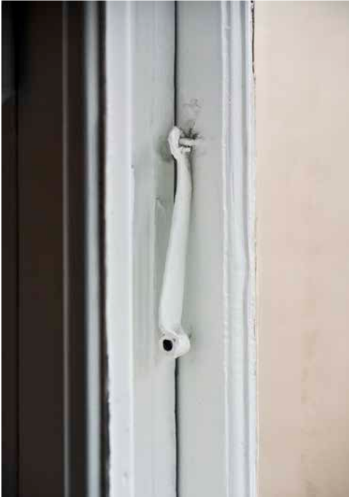
FÖNSTRENS YTTERBÅGAR ÄR BEVARADE FRÅN ÄLDRE TID MED HASPAR AV EN TYP SOM VARN VANLIGA UNDER 1700-TAL OCH TIDIGT 1800-TAL. FOTO: J. MALMBERG.
