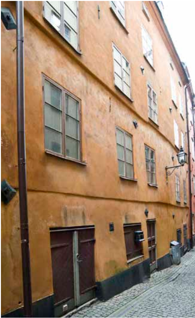
FASADEN MOT GÖRAN HÄLSINGES GRÄND. FÖNSTREN LIGGER PRECIS I MURLIVET. HÄR SYNS OCKSÅ DE DUBBLA UTKRAGNINGARNA TYDLIGT. DE GJORDES UNDER MEDELTIDEN SANNOLIKT FÖR ATT FÅ STÖRRE RUM HÖGRE UPP I HUSEN. FOTO J. MALMBERG.
