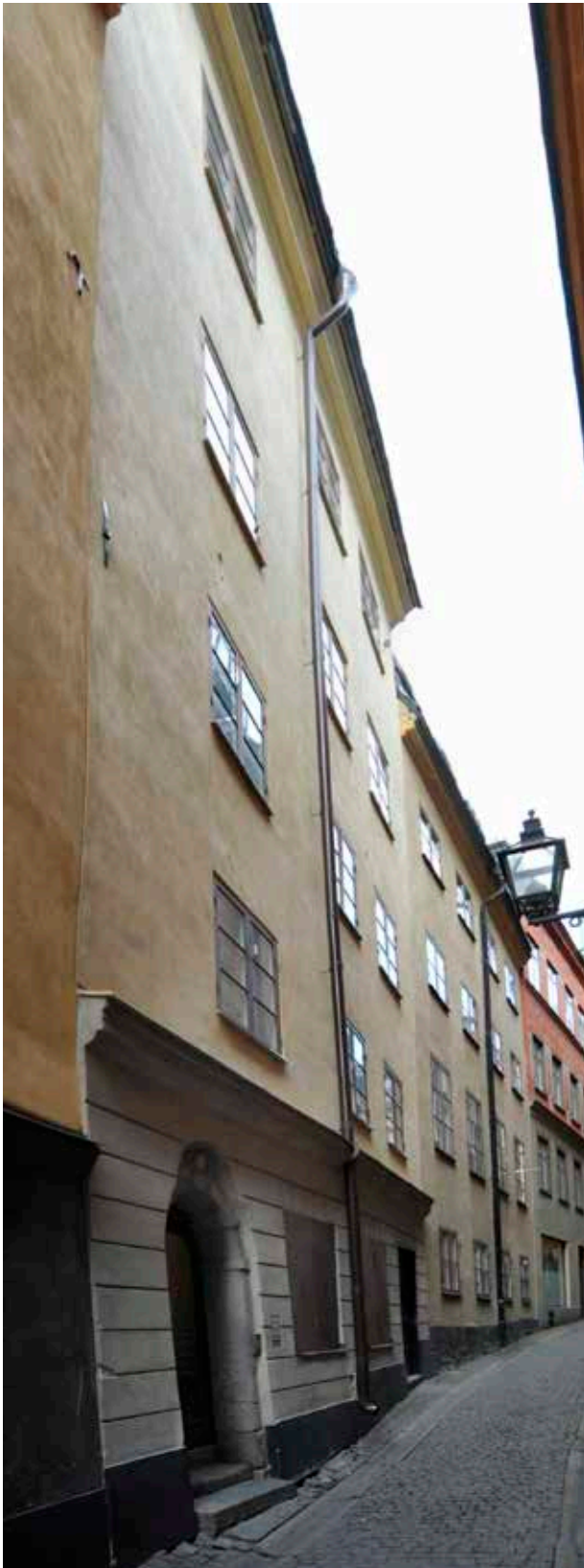
FASADEN MOT GÖRAN HÄLSINGES GRÄND ÄR SLÄTPUTSAD OVANFÖR DEN RUSTICERADE BOTTENVÅNINGEN. TILL PORTEN LEDER TVÅ TRAPPSTEG AV NATURSTEN UPP. FOTO: J. MALMBERG.
