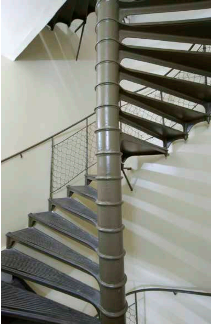
GJUTJÄRNSTRAPPAN ERSATTE 1882 DE TRÄTRAPPOR SOM FANNS I DE ÖVRE VÅNINGARNA. TILL DEN FÖRSTA VÅNINGEN OMNÄMNS STENTRAPPAN REDAN I DE ÄLDSTA BRANDFÖRSÅKRINGARNA. FOTO: J. MALMBERG.
