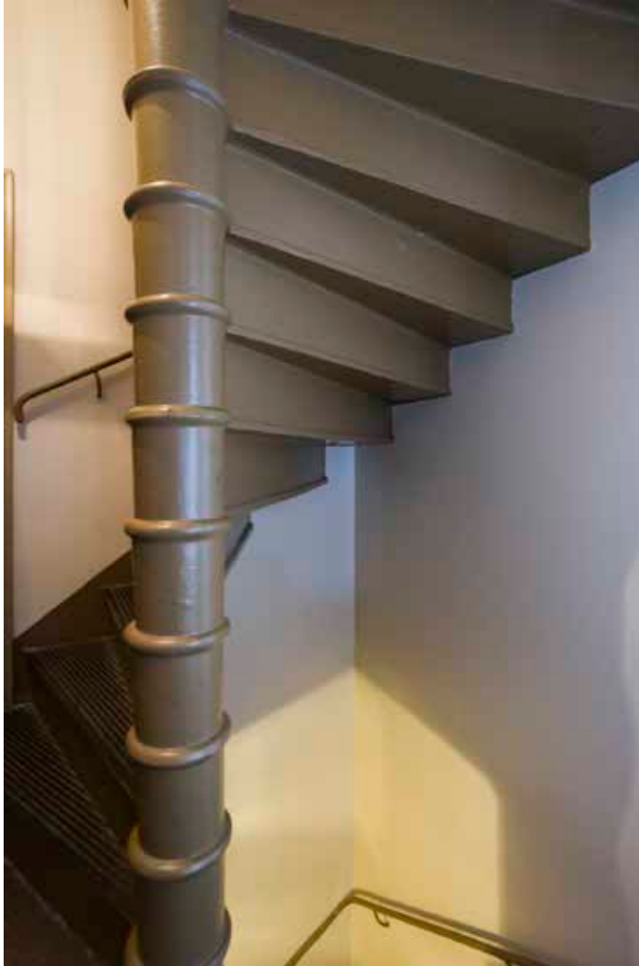
EN SPIRALTRAPPA AV JÄRN ERSATTE DE BRANDFARLIGA TRÄTRAPPORNA ÅR 1891. TRAPPLOPPET ÄR SMALT OCH TRÄNGT MEN DET FINNS ÄNDÅ HÖGA PARDÖRRAR TILL NÅGRA LÄGENHETER. FOTO: J. MALMBERG.
