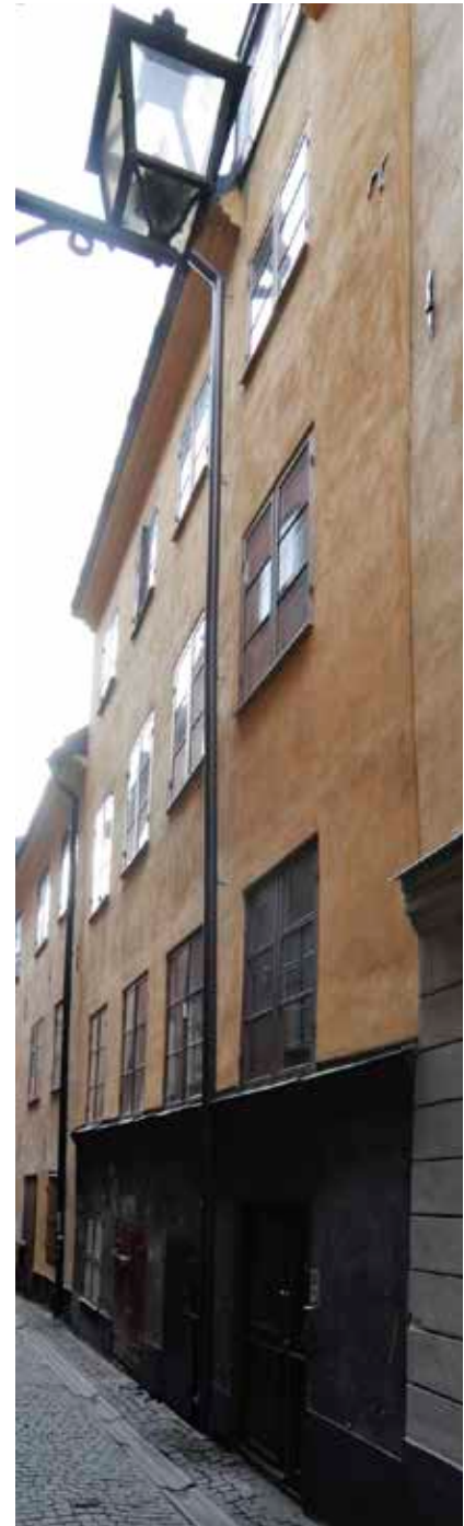
FASADEN MOT GÖRAN HELSINGES GRÄND ÄR ENKEL OCH SLÄTPUTSAD. DE DELVIS SYNLIGA ANKARSLUTARNA TYDER PÅ EN OMBYGGNAD ELLER MÖJLIGEN NYBYGGNAD UNDER 1600-TALET. FOTO: J. MALMBERG.
