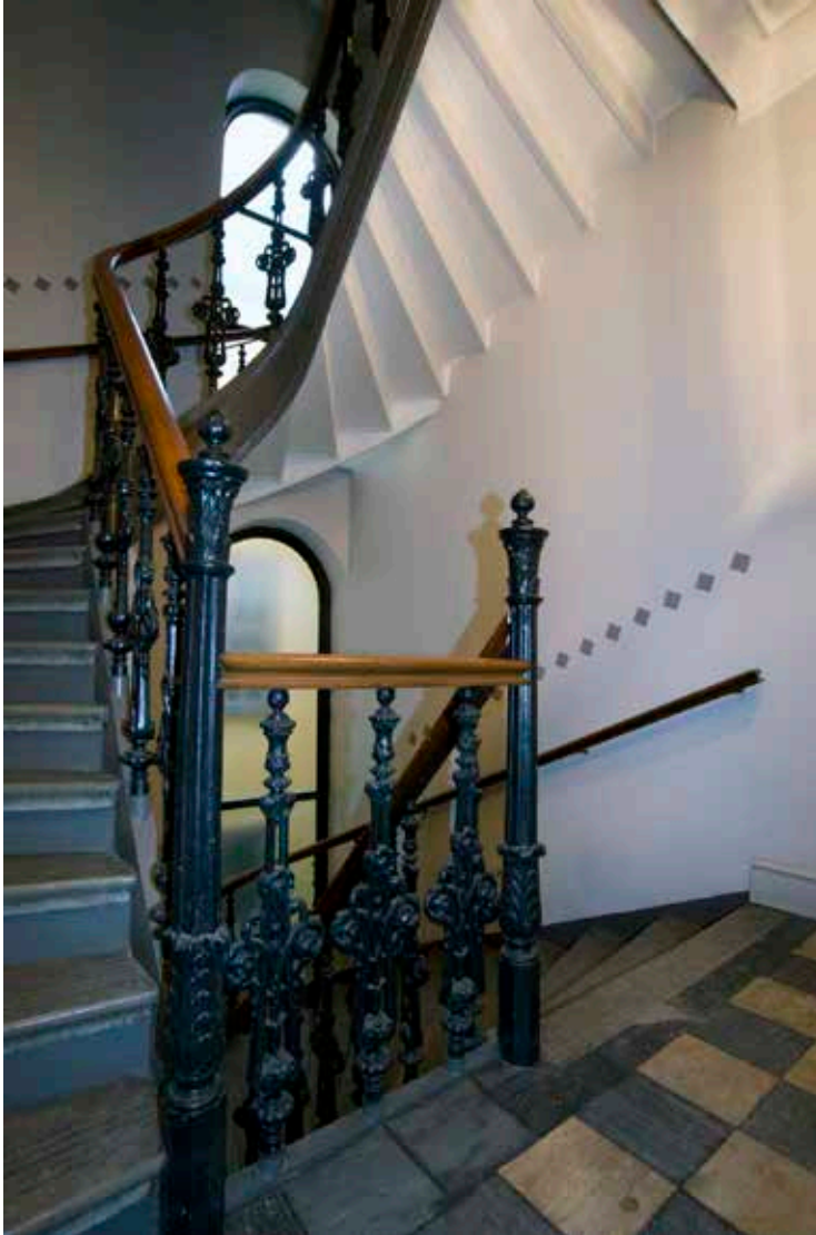
PÅ 1880-TALET FICK GATHUSET ETT NYTT TRAPPLOPP, HÄR SETT FRÅN VILPLANET PÅ VÅNING 1 TRAPPA. RÄCKET AV JÄRN HAR HANDELDARE AV VALNÖTSTRÄ. FOTO: J. MALMBERG.
