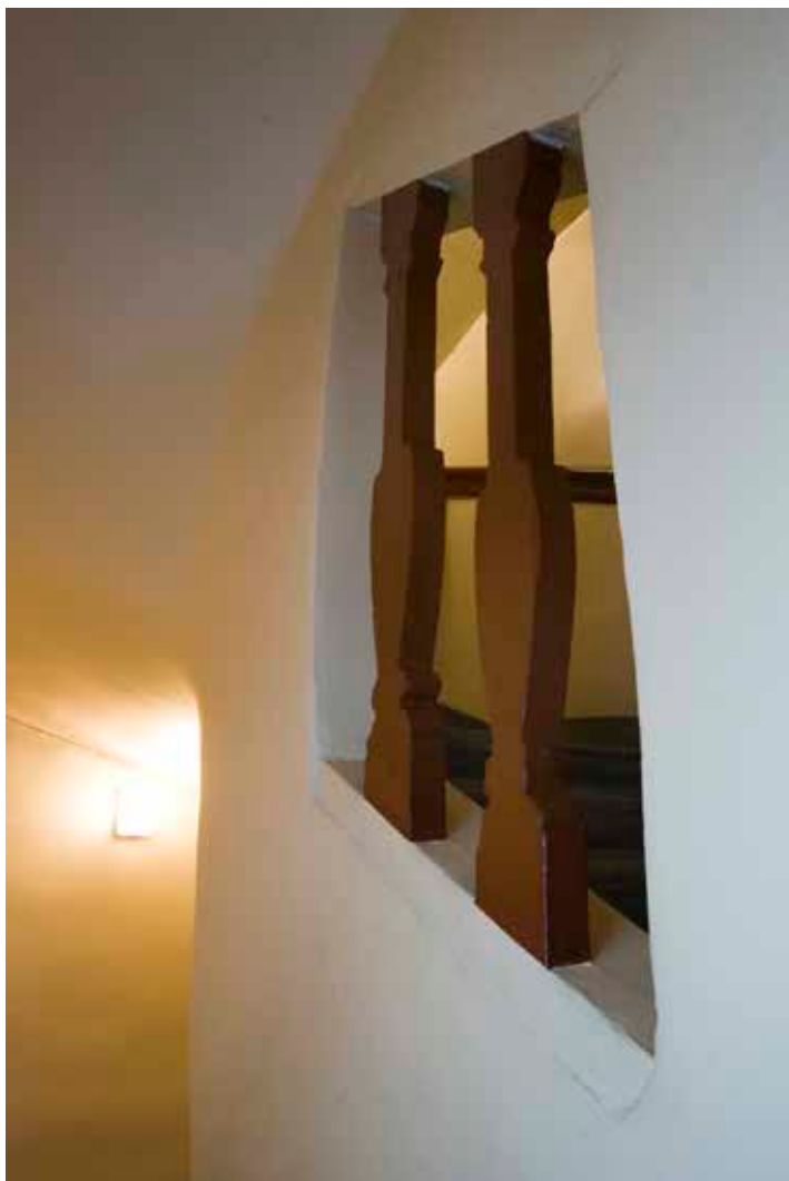
TRAPPHUSET I GRÄNDHUSET MOT HELGA LEKAMENS GRÄND UPPFÖRDES 1758 DÅ STENTRAPPAN ERSATTE TRÄTRAPPOR. DEN HÄR TYPEN AV RÄCKE AV FIGURSÅGDE BALUSTRAR AV NÄRMEST SENBAROCK TYP FÖREKOMMER UNDER HELA 1700-TALET. FOTO: J. MALMBERG.
