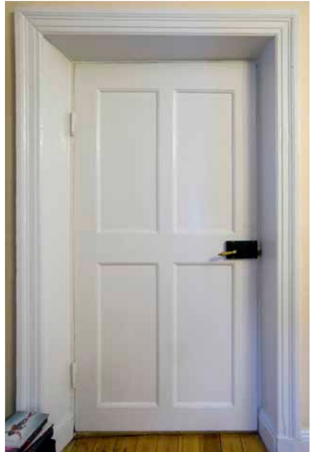
DÖRRFODRET PÅ BILDEN ÄR FRÅN TIDIGT 1800-TAL MEDAN DÖRRBLADET MED FYRA UTANPÅLIGGANDE Fyllningar ÄR ÄLDRE, FRÅN 1700-TALET ELLER 1600-TALET. FOTO: J. MALMBERG.
