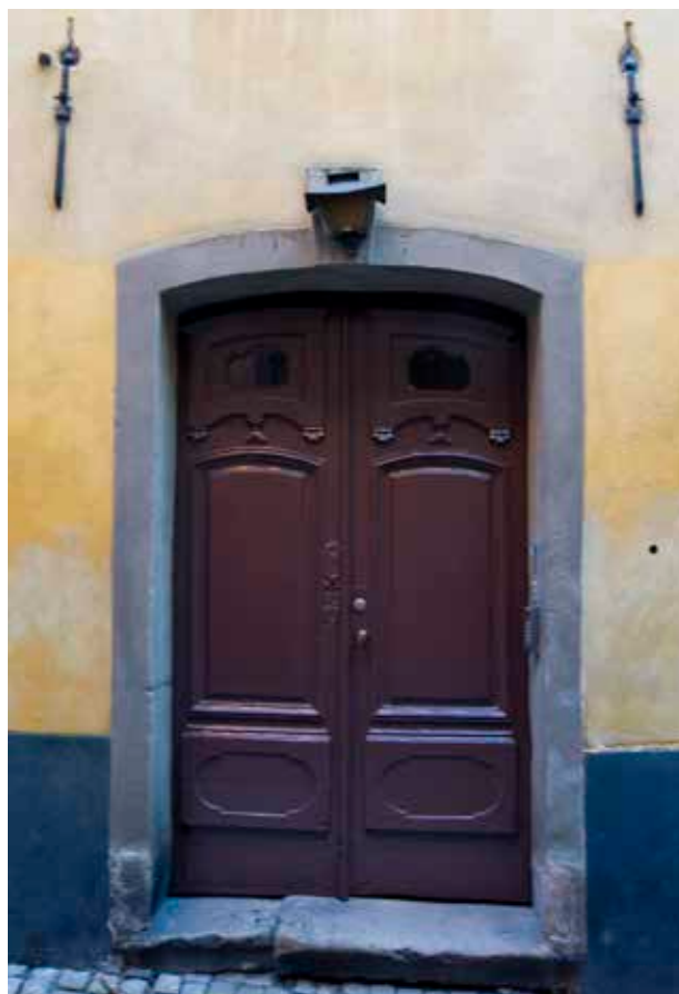
ANKARSLUTARNA I FASADEN ÄR FRÅN 1600-TALET MEN PORTEN MED OMFATTNING SATTES IN VID OMBYGGNADEN 1758. FOTO: J. MALMBERG.
