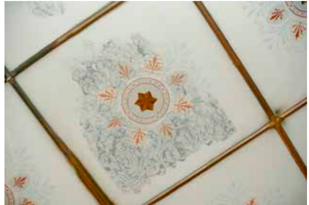
GATHUSETS SÖDRA BUTIKSLOKAL HAR ETT SPRÖJSAT OCH MÅLAT GLASTAK SOM FÖRMODLIGEN SATTES UPP PÅ 1880-TALET. FOTO: J. MALMBERG.
