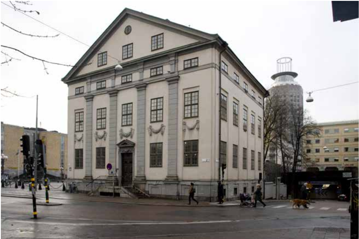
HUVUDFASADEN MOT GÖTGATAN ÄR DEN MEST UTSMYCKADE, MED FRUKTFESTONGER OCH PILASTRAR. FOTO: J. MALMBERG.
