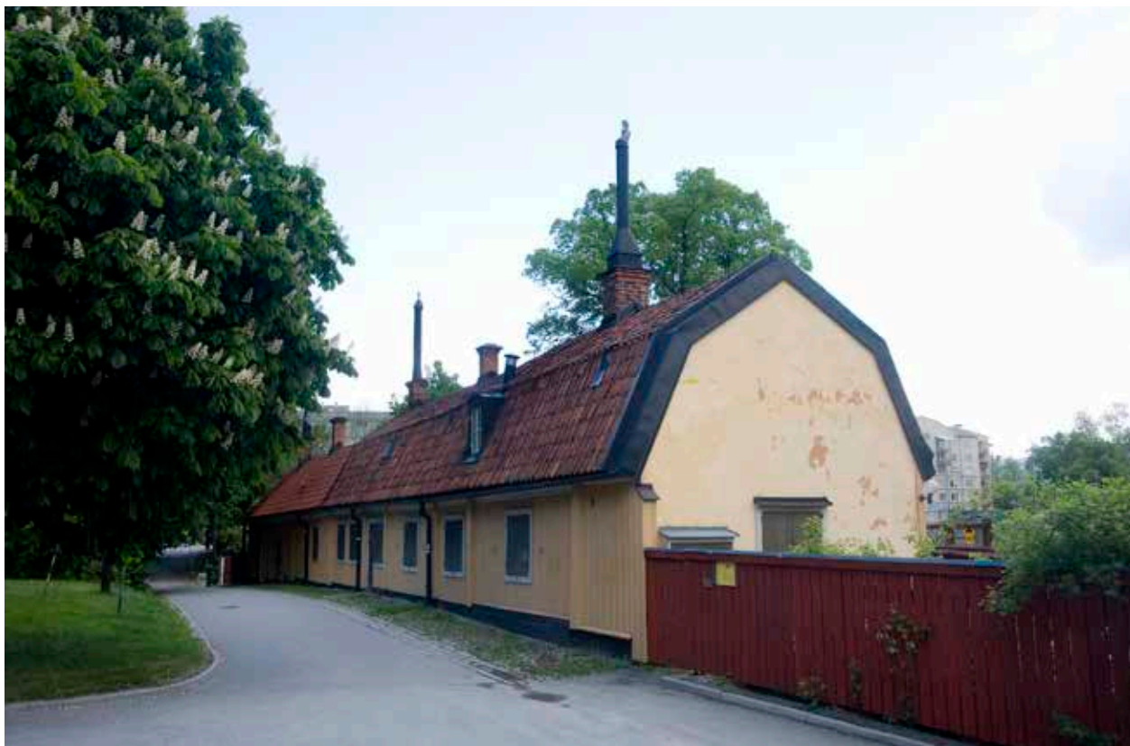
FASADEN MOT EKERMANS GRÄND MED DEN VÄSTRA DELEN NÄRMAST. FOTO J. MALMBERG.
