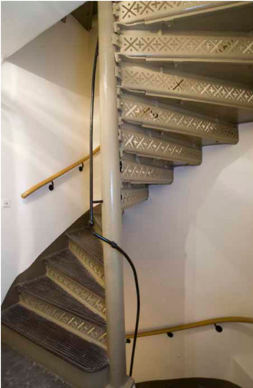
PÅ 1860-TALET BYTTES TRÄTRAPPORNA I DE ÖVRE VÅNINGARNA MOT EN SPIRALTRAPPA AV GJUTJÄRN. FOTO: J. MALMBERG.
