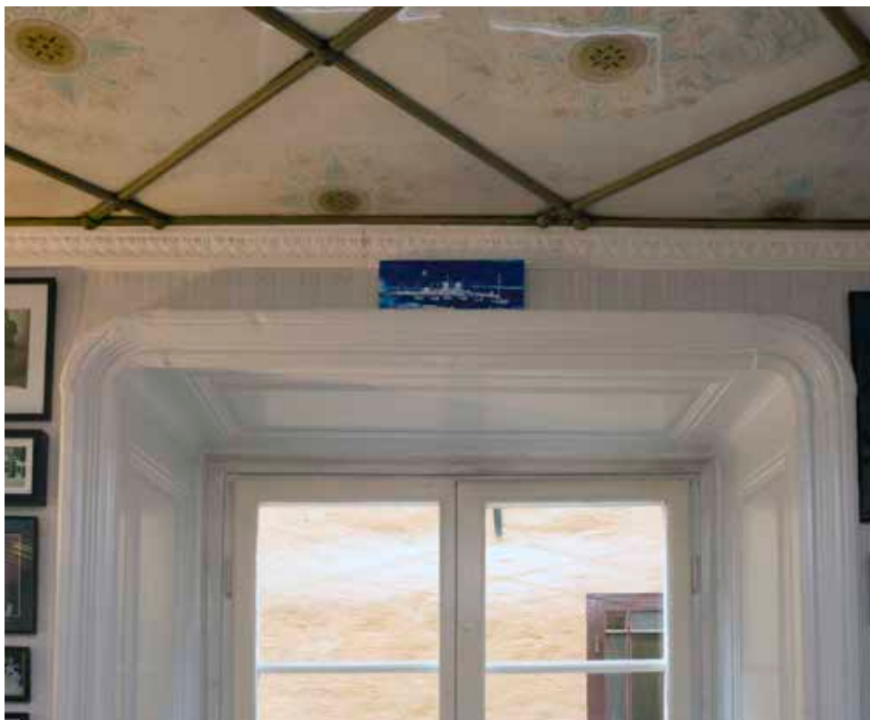
GLASTAKET PÅ VÅNING 1 TRAPPA TYDER PÅ ATT LOKALEN KAN HA ANVÄNTS SOM KONTOR VID SEKELSKIFTET 1900. PÅ BILDEN SYNS ÄVEN FÖNSTERFODREN MED RUNDADE ÖVERKANTER. FOTO: J. MALMBERG.
