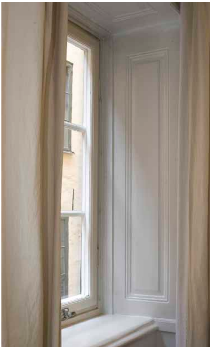
FÖNSTERÖPPNINGARNAS SMYGPANELER OCH FODER ÄR FRÅN 1700-TALET SMT MEN BÅGAR OCH KARMAR ÄR SENTIDA. FOTO: J. MALMBERG.
