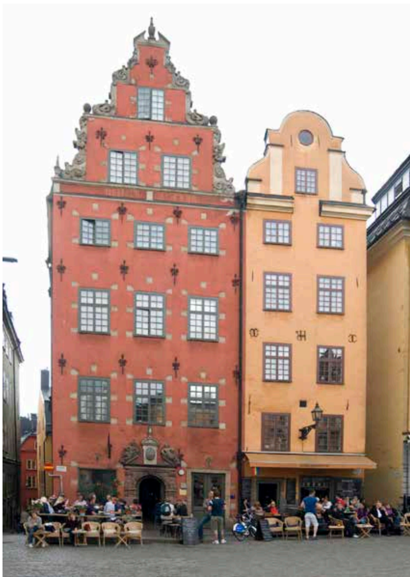
FASTIGHETENS FASADER MOT STORTORGET. FOTO J. MALMBERG.
