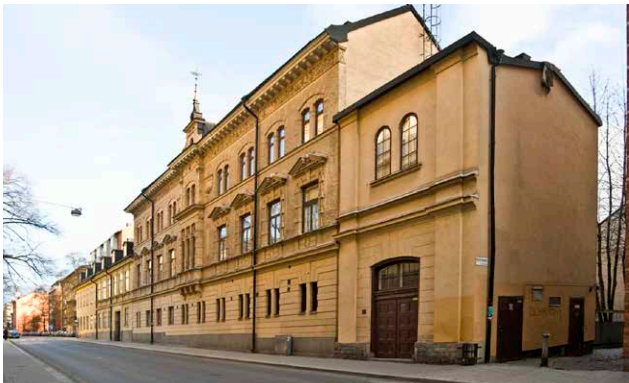
HÖGBERGSGATAN FRÅN VÄSTER. NÄRMAST DEN LILLA BYGGNADEN 3B, BORTOM LIGGER DET NYA BOSTADSHUS SOM BRYGGAREN FRITZ DÖLLING LÄT UPPFÖRA 1885 (3A). YTTERLIGARE TILL VÄNSTER GATHUS 2 OCH 3. FOTO: J. MALMBERG.
