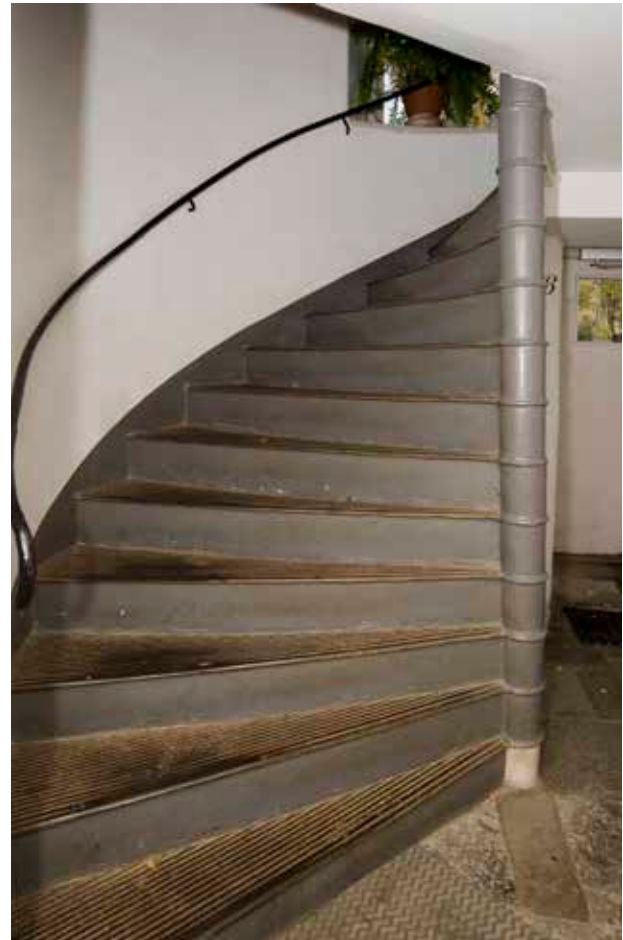
TRAPPA AV GJUTJÄRN I VÄSTRA TRAPPHUSET. FOTO J. MALMBERG.
