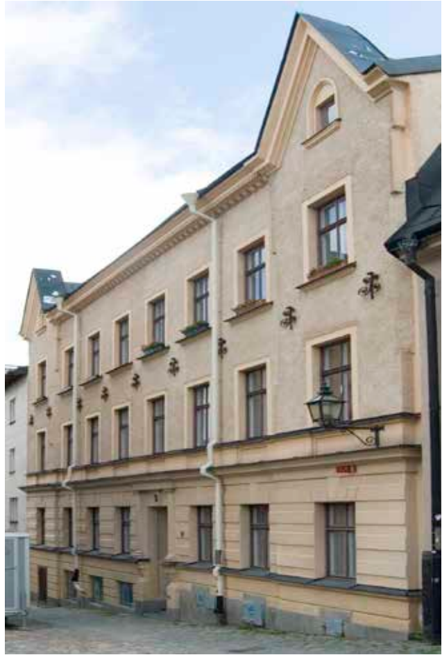
DEN TIDSTYPISKA FASADEN MED KRAFTIGT UTFORMAD BOTTENVÅNING OCH SLÄTARE PUTSYTOR HÖGRE UPP MED DJUPT LIGGANDE FÖNSTER. FOTO J. MALMBERG.
