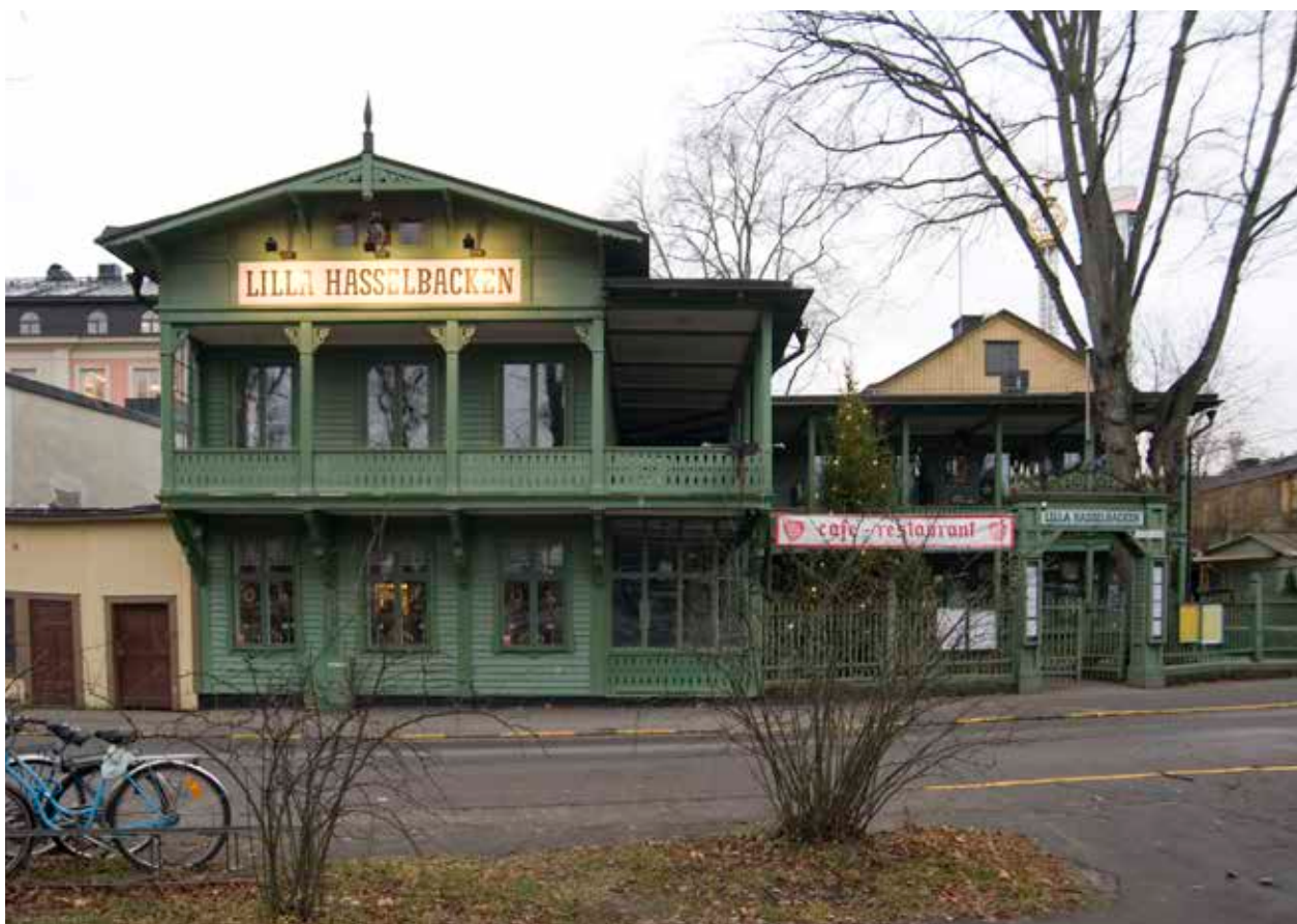
HUVUDFASADEN MED PUNCHVERANDOR MOT DJURGÅRDSSLÄTTEN. FOTO. J MALMBERG
