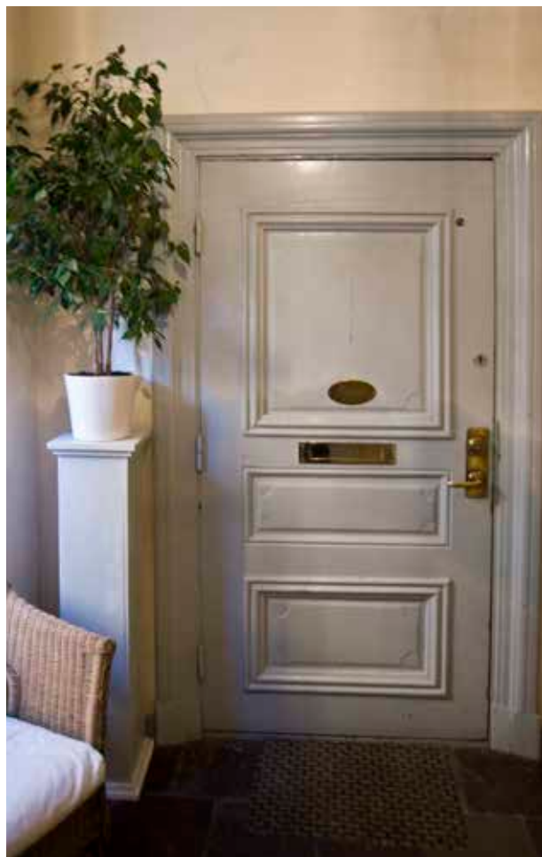
HELFRANSK LÄGENHETSDÖRR FRÅN 1700-TALET I FÖRE DETTA CYGNUS 3. DE TRE Fyllningarna har nupna hörn. Dörrfodret är samtida men gångjärnen utbytta. FOTO: J. MALMBERG.
