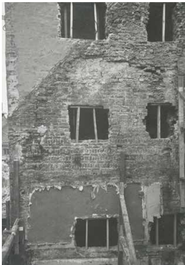
DEN BLOTTADE YTTERMUREN TILL CYGNUS 3 SEDAN DELAR AV CYGNUS 1 RIVITS. OKÄND FOTOGRAF 1938. SSM:S ARKIV. F 20878.
