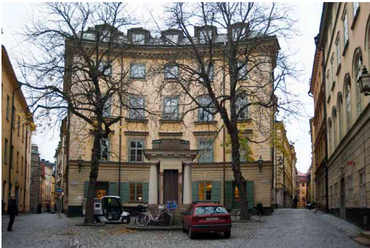
FASAD MOT TYSKA BRUNNSPLAN, FÖRE DETTA CYGNUS 2 OCH 3. FASADENS UTFORMNING ÄR BASERAD PÅ RITNINGAR AV ERIK PALMSTEDT MEN FÖNSTERÖPPNINGARNA PÅ VÅNING 2 OCH 3 TRAPPOR BLEV I PRAKTIKEN OLIKA STORA I DE TVÅ BYGGNADERNA. FOTO: J. MALMBERG.
