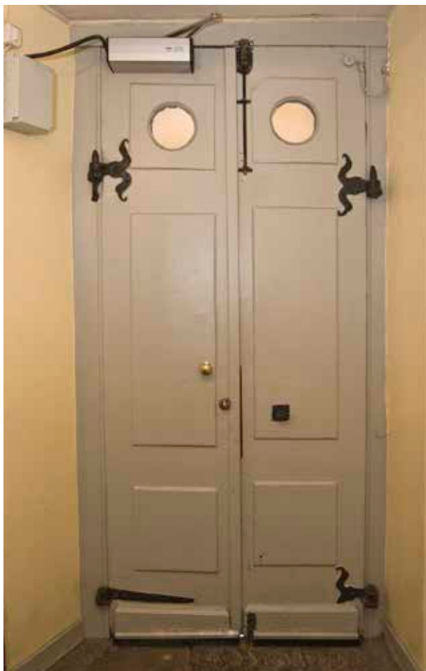
INSIDAN AV PORTEN TILL SVARTMANGATAN 25, FÖRE DETTA CYGNUS 2. HELFRANSK PARDÖRR FRÅN 1700-TALET MED SAMTIDA GÅNGJÄRN. FOTO: J. MALMBERG.
