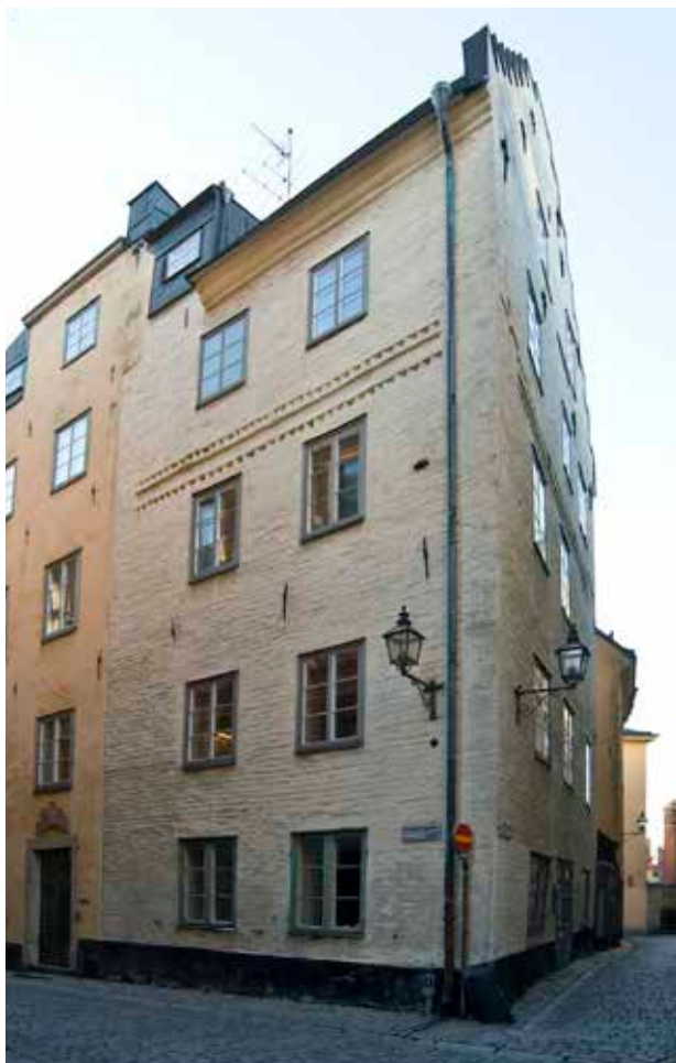
FÖRE DETTA CYGNUS 3 MED TRAPPGAVEL MOT TYSKA SKOLGRÄND SAMT BLINDERINGSBAND OCH SÅGSKIFT MELLAN VÅNING 2 OCH 3 TRAPPOR. Huset består av två sammanslagna medeltida hus vilket har markerats med olika fasadbehandling. Det norra huset är slamt i ljus ton, det södra putsat med gul slätputs. FOTO: J. MALMBERG.
