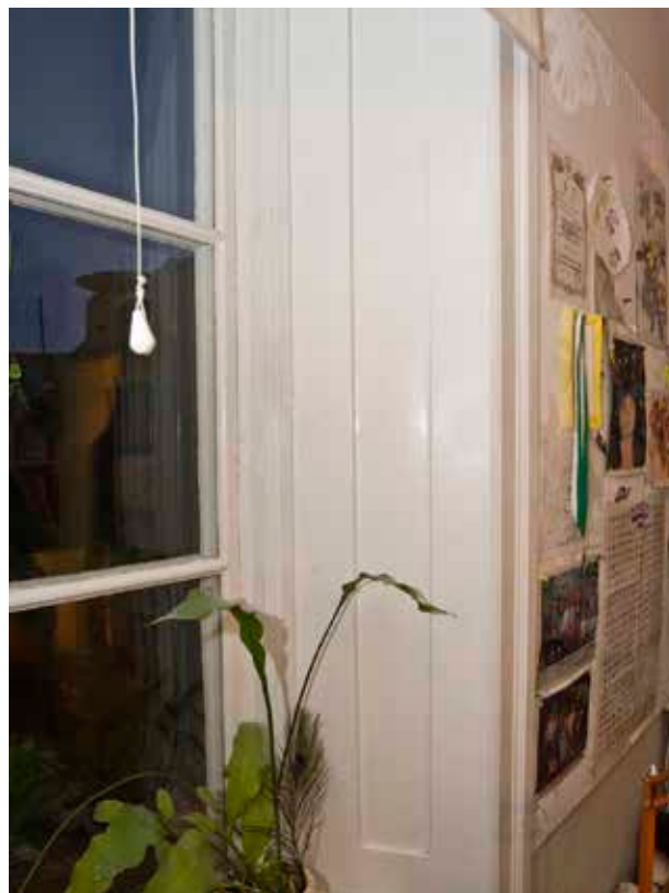
STENPROFILERAD FÖNSTERSMYGPANEL FRÅN 1800-TALET PÅ VÅNING 2 TRAPPOR. FOTO: J. MALMBERG
