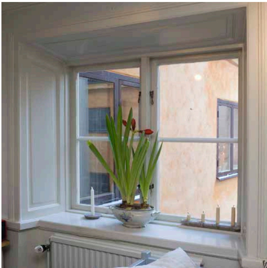
DE ENKLA FÖNSTERPANELERNA ÄR SANNOLIKT FRÅN 1800-TALET LIKSOM FÖNSTERFODREN. FOTO: J. MALMBERG.
