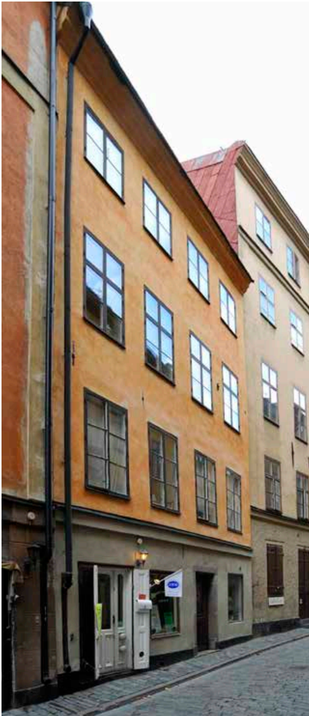
DE TVÅ GATHUSEN HAR LIKANDE FASADUTFORMNINGAR MEN MOT SVARTMANGATAN FINNS BUTIKSLOKALER I BOTTENVÅNINGEN. DÖRRARNA TILL TRAPPHUS OCH BUTIK ÄR SAMTIDA, FRÅN 1800-TALET SLUT. FOTO: J. MALMBERG.
