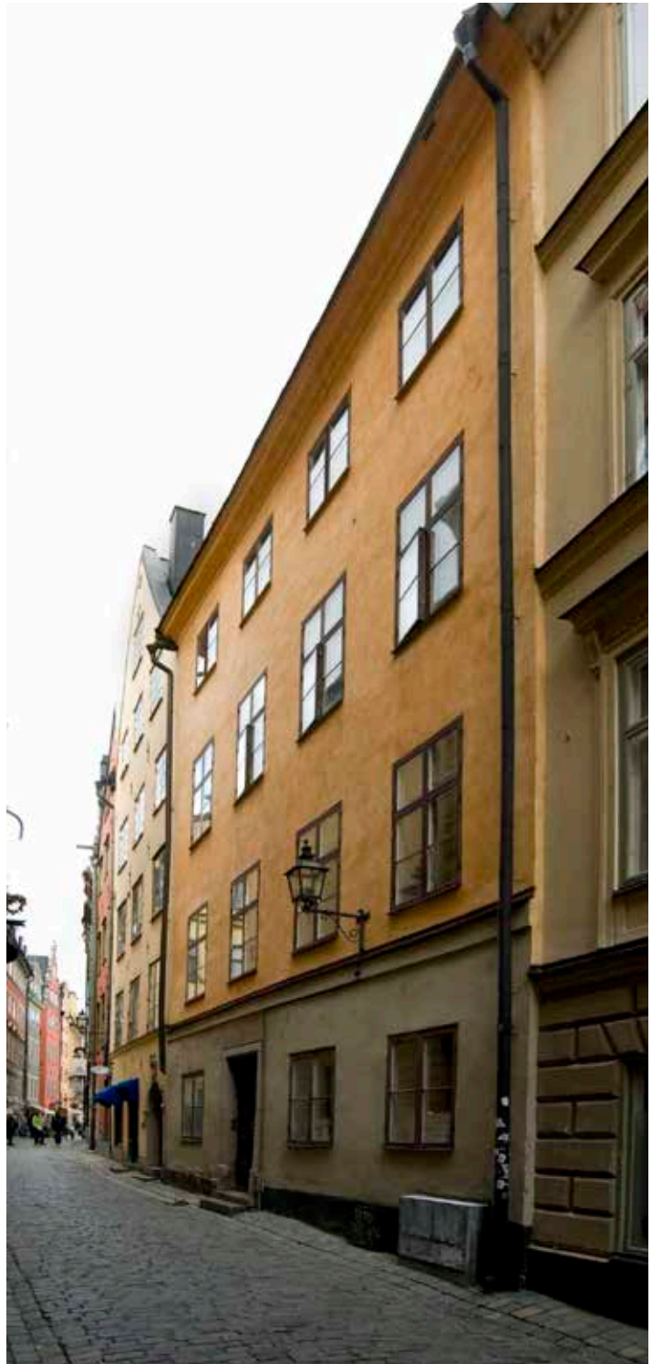
FRÅN SKOMAKARGATAN LEDER NÅGRA TRAPPSTEG UPP TILL PORTEN. LÄNGRE NORRUT ÄR SOCKELN AV STEN OPUTSAD OCH FÖRMODLIGEN BEVARAD SEDAN 1600-TALET. FOTO: J. MALMBERG.
