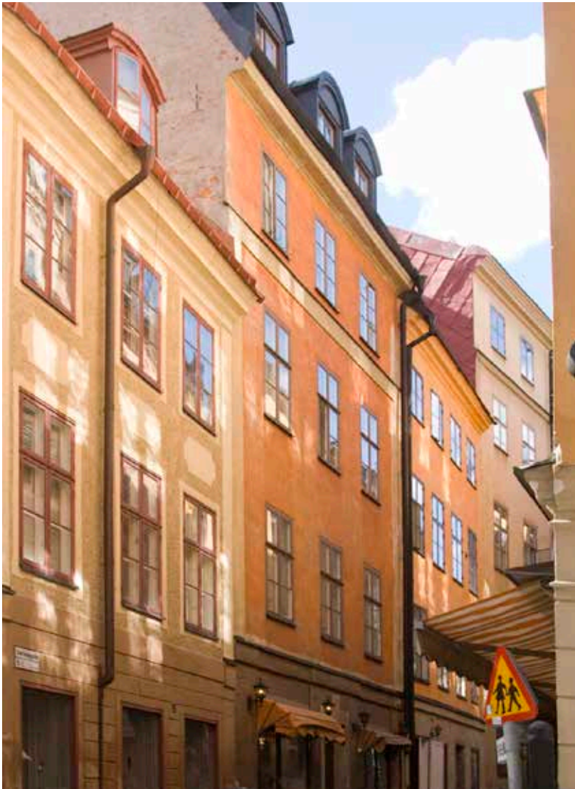
FASAD MOT SVARTMANGATAN. FOTO: J. MALMBERG.
