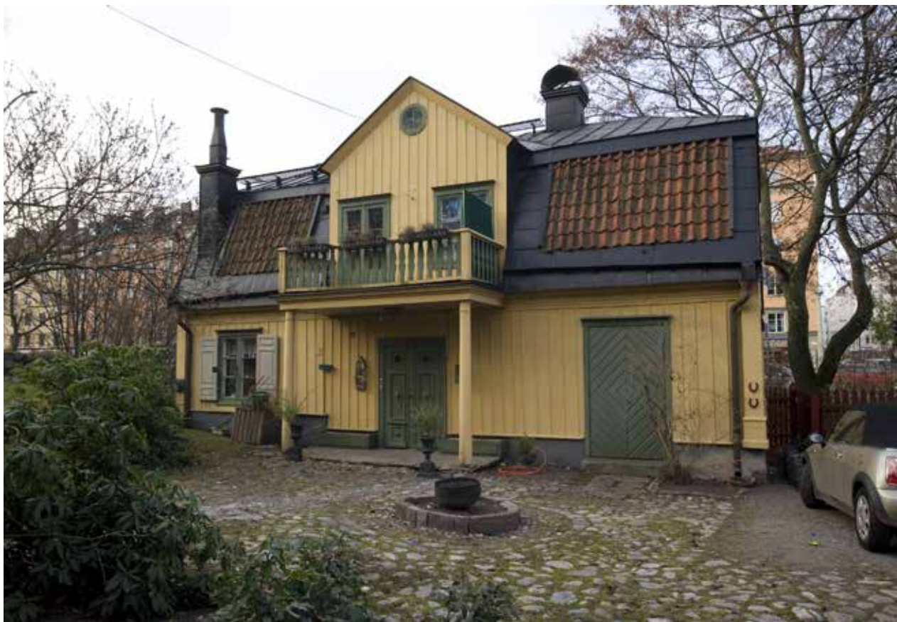
BOSTADSHUSET MED TIDSTYPISK 1700-TALS FASAD, FÖNSTER OCH BRUTET TAK. ENTRÉPARTI MED BALKONG BYGGDES ÅR 1940, SAMTIDIGT SOM DEN HÖGRA DÖRREN SATTES IN TILL EN INNANFÖRLIGGANDE ATELJÉ. FOTO. J MALMBERG.
