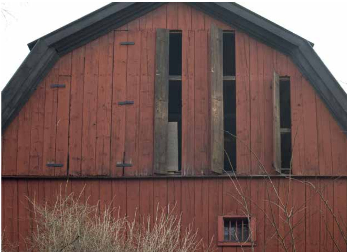
TOBAKSLADANS VIND DÄR TOBAKSBLADEN TORKADES MED HJÄLP AV ÖPPNINGSBARA LUCKOR I GAVELN. FOTO. J MALMBERG.
