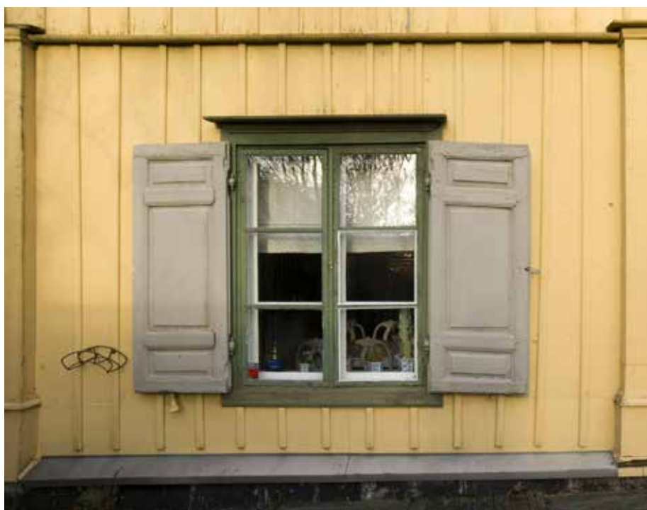
FÖNSTER OMGIVET AV FÖNSTERLUCKOR MED TRE FYLLNINGAR OCH SMIDDA BESLAG. FÖNSTRET OMGES AV PROFILERADE FODER OCH EN DEKORATIV VATTBRÄDA OVANFÖR. FOTO. J MALMBERG.
