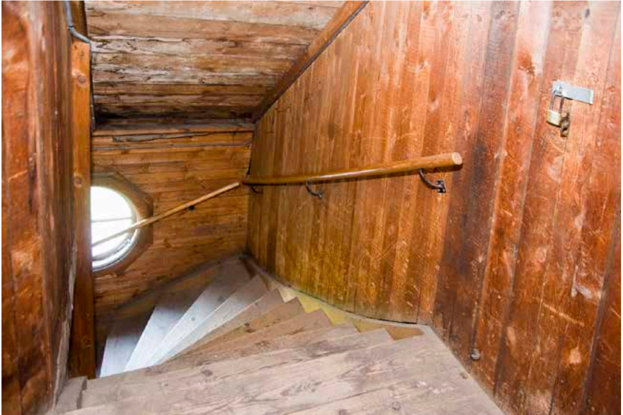
BRÄDKLÄDD OCH OMÅLAD TRAPPA TILL VINDEN. FOTO J. MALMBERG.
