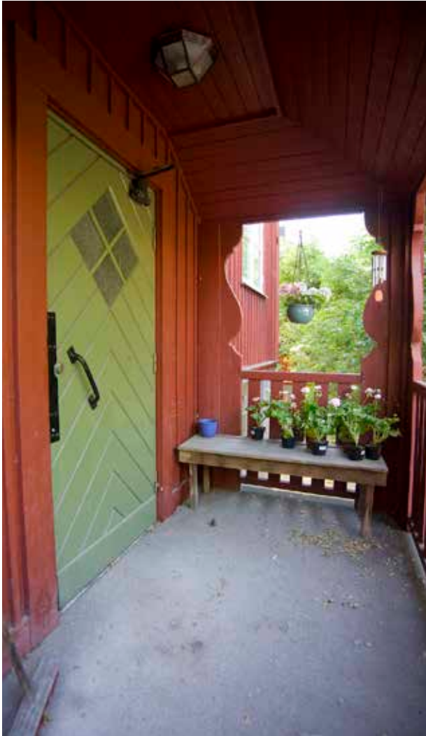
FÖRSTUKVIST MED KONTURSÅGADE BRÄDER SOM DEKOR OCH URSPRUNGLIG DÖRR MED DRAGHANDTAG. FOTO J. MALMBERG.
