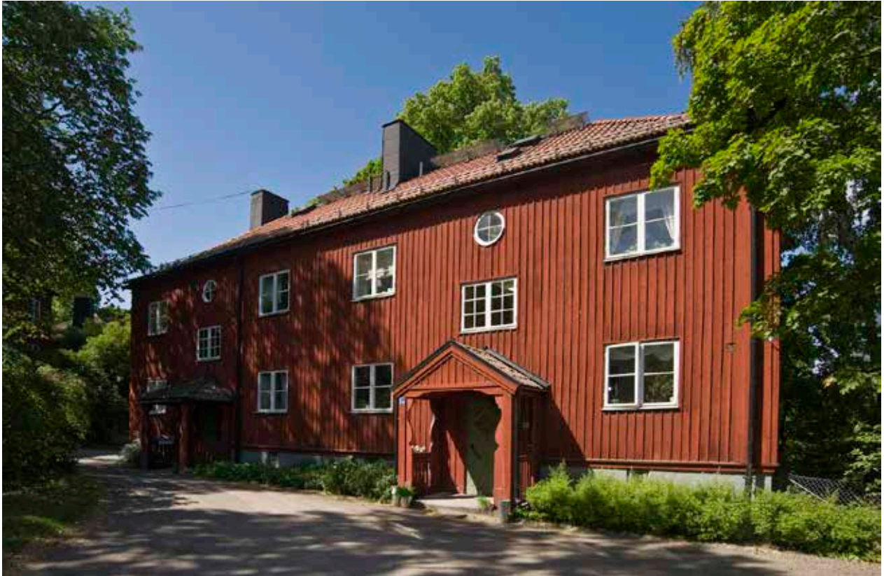
FASAD MED LOCKLISTPANEL OCH URSPRUNGLIGA FÖNSTER. FOTO J. MALMBERG.
