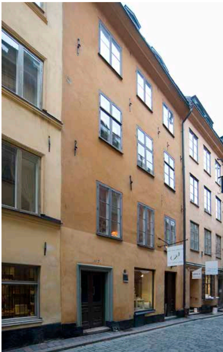
GATHUSETS FASAD MOT KINDSTUGATAN ÄR SLÄT-PUTSAD OVANFÖR EN LÅG SANDSTENS SOCKEL. FOTO: J. MALMBERG.
