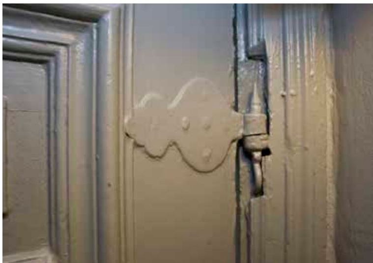
HELFRANSK ENKELDÖRR FRÅN OMKRING 1700 MED SAMTIDA PLATTGÅNGJÄRN. TRAPPHUSET, VÅNING 3 TRAPPOR. FOTO: J. MALMBERG.
