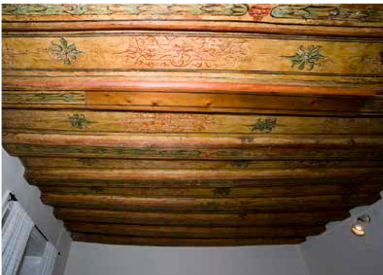
DEKORERAT BJÄLKTAK FRÅN 1600-TALET MITT ELLER ANDRA HÄLFT, VÅNING 2 TRAPPOR. FOTO: J. MALMBERG.
