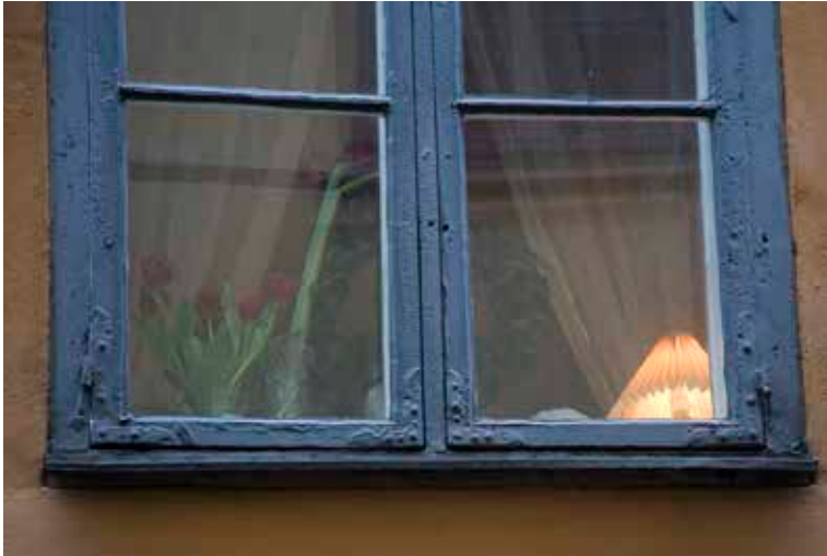
FÖNSTERÖPPNING MOT KINDSTUGANTAN MED ÄLDRE KARM OCH BÅGAR. FÖNSTERBESLAGEN OCH GÅNGJÄRNET ÄR AV SEN 1700-TALSTYP. FOTO: J. MALMBERG.
