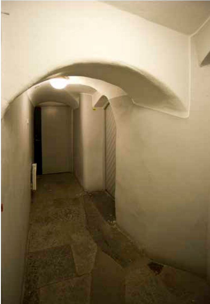
PORTGÅNGEN SEDD FRÅN GATAN. FOTO J. MALMBERG.
