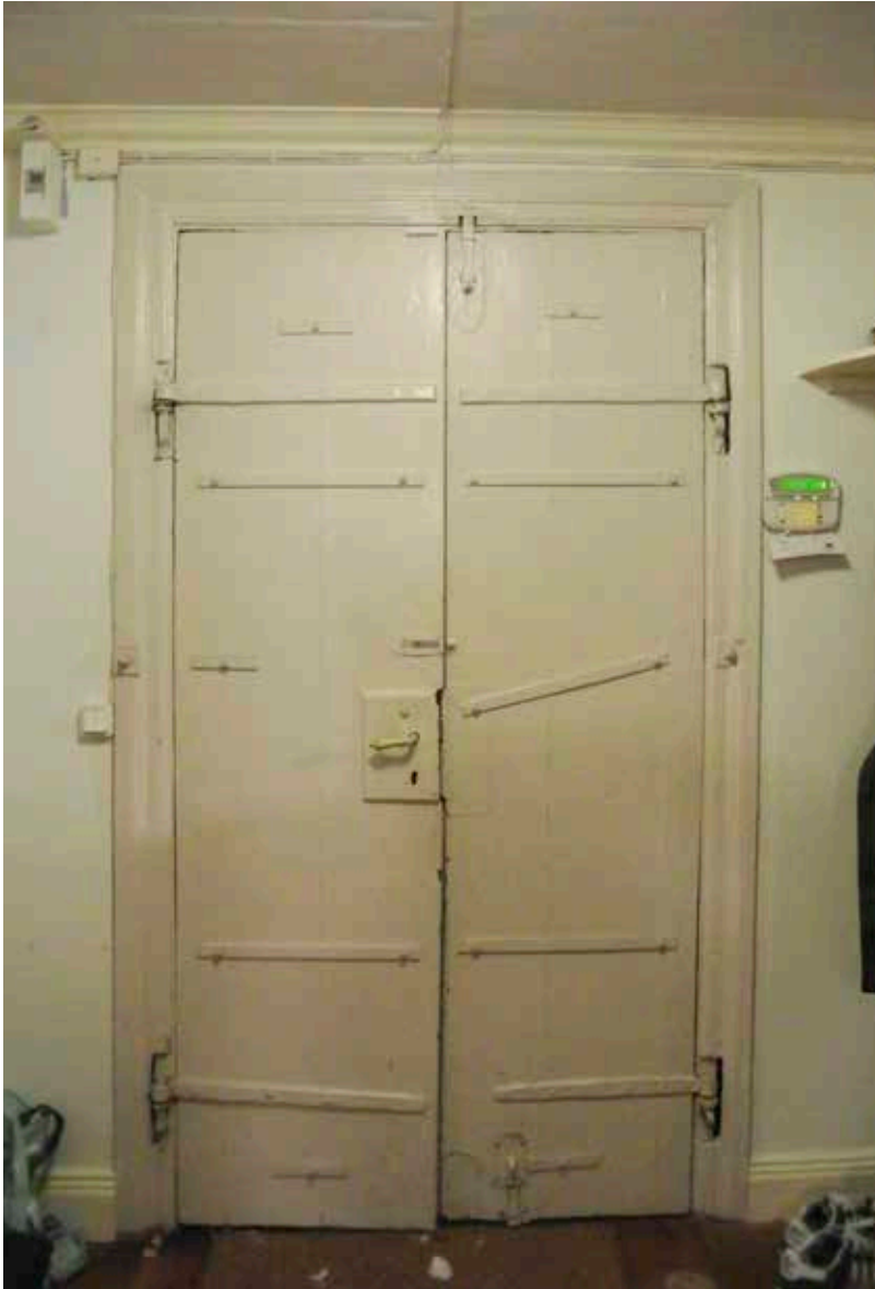
DE INRE ENTRÉDÖRRARNA FRÅN INSIDAN. DÖRRARNA ÄR ENKLA OCH AV ÄLDRE KARAKTÄR. DÖRRFODRET TILLHÖR BYGGNADENS ÄLDSTA, AV SENGUSTAVIANSK TYP, OCH DET SKULLE KUNNA VARA FRÅN TIDEN FÖR ANLÄGGNINGEN AV BEGRAVNINGSPLATSEN. MOT PLANKTAKET SITTER EN PROFILERAD TAKLIST AV TRÄ. FOTO J. MALMBERG.
