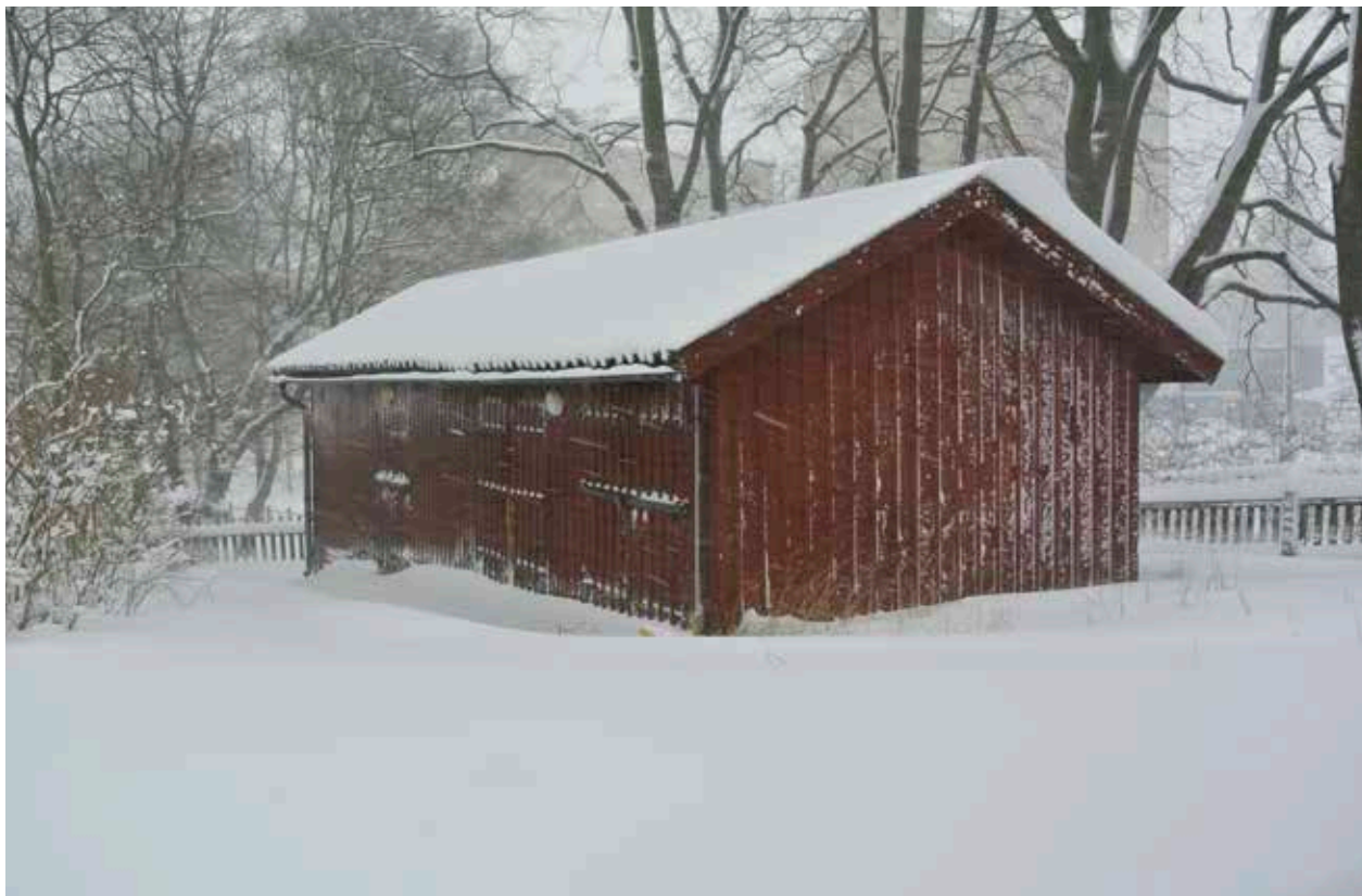
UTHUSETS FASADER MOT NORR RESPEKTIVE VÄSTER. UTHUSET HAR TRE DÖRRAR SOM URSPRUNGLIGEN LEDDE TILL ETT AVTRÄDE, ETT FÖRRÅD OCH EN VEDBOD. FOTO J. MALMBERG
