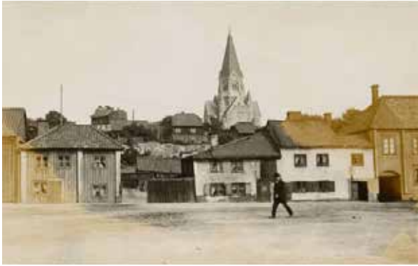
VY MOT ÖSTER TAGET MELLAN ÅREN 1901–1921. NÅGRA AV HUSEN HAR FÖNSTERLUCKOR OCH SAMTLIGA PÅ BILD HAR ETT DÖRRPARTI/KÖRPORT I GATUFASADEN. (SSMFA 43098)
