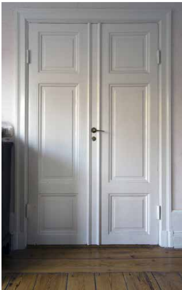
INTERIÖR FRÅN NYTORGET 3 SOM PRÄGLAS AV EN RENOVERING UNDER 1800-TALET MED PARDÖRRAR, FODER, SOCKLAR OCH BRÄDGOLV. FOTO: J. MALMBERG
