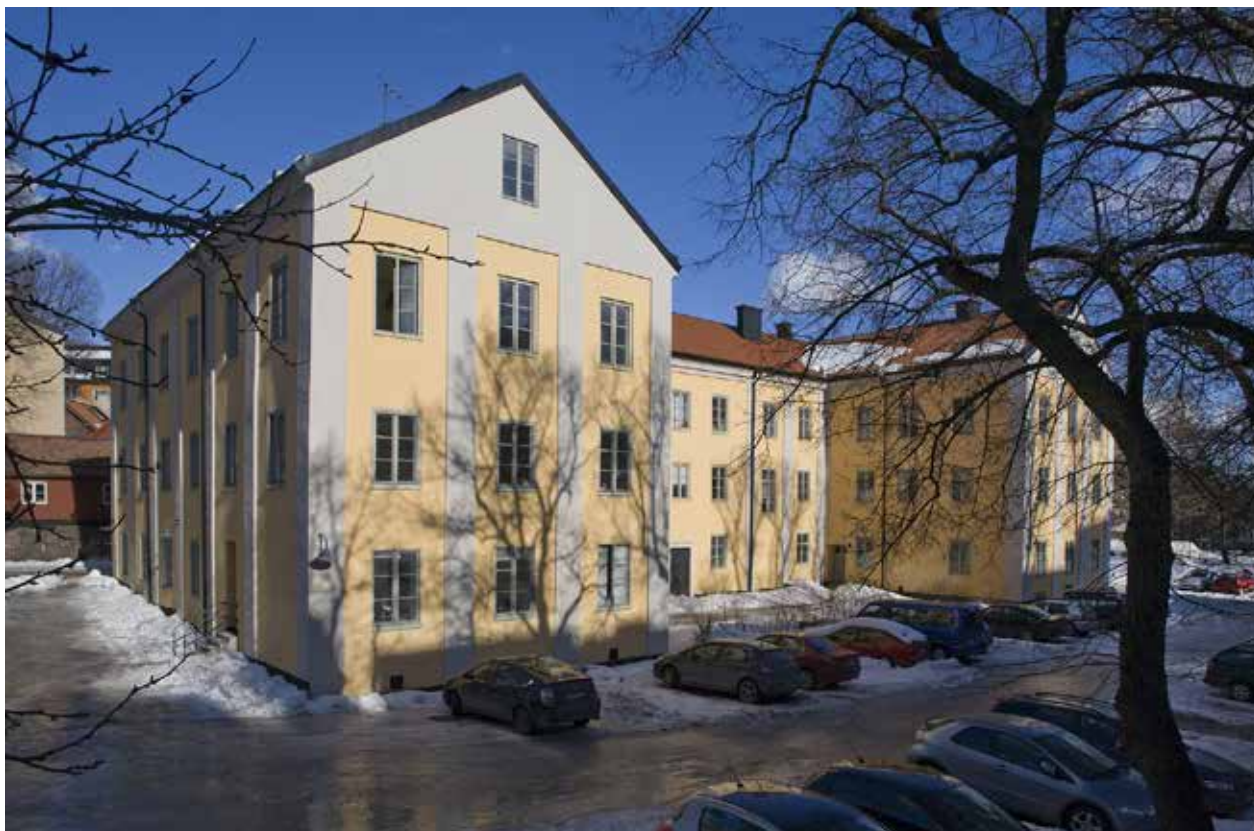
BONDESONEN STÖRRE 19 BESTÅR AV EN HUVUDBYGGNAD OCH TVÅ FLYGLAR. BYGGNADEN UPPFÖRDES MED PUTSADE FASADER INDELADE MED LISENER MEN VAR FRÅN BÖRJAN TVÅ VÅNINGAR HÖG. FOTO: G. FREDRIKSSON, STOCKHOLMS STADSMUSEUM.
