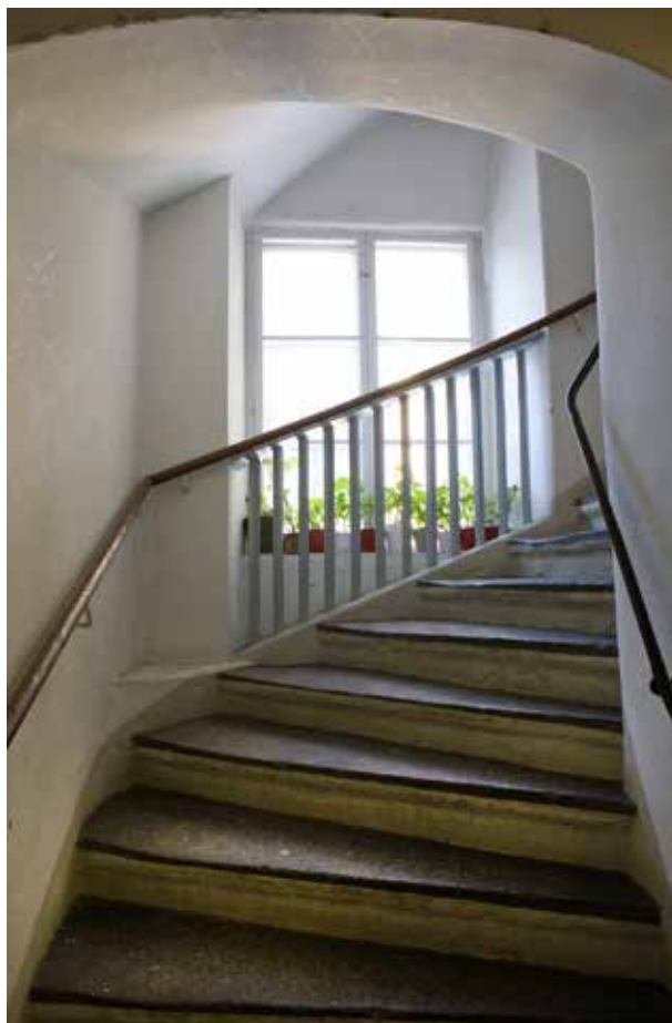
TRAPPLOPPEN HAR STEG AV KALKSTEN OCH RÄCKEN AV SNED-STÄLLDA TRÄRIBBOR. FOTO: G. FREDRIKSSON, STOCKHOLMS STADSMUSEUM.
