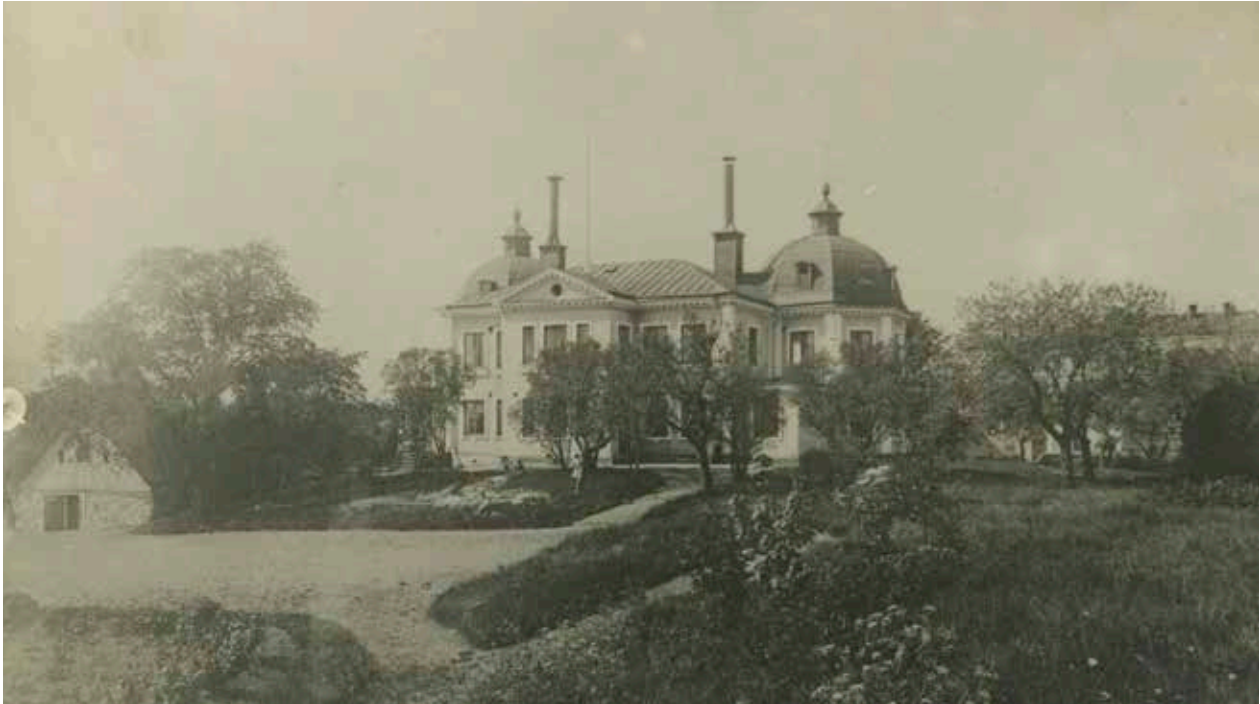
ÄLDRE FOTOGRAFI AV BLECKTORNETS ÖSTRA FASAD. AV BILDEN KAN MAN SKÖNJA ATT BLAND ANNAT FÖNSTEROMFATTNINGARNA HADE ETT ANNAT UTSEENDE ÄN I DAG. ANONYMT FOTO U.Å., SSM FA 4177.
