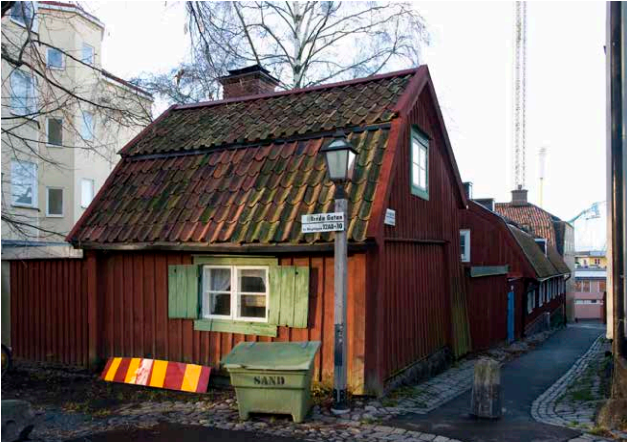
ÖSTRA VARVSGATAN 1A MED SITT BRUTNA TEGELTAK, PANELKLÄDDA FASAD OCH SPRÖJSADE FÖNSTER MED FÖNSTERLUCKOR. FOTO J. MALMBERG.
