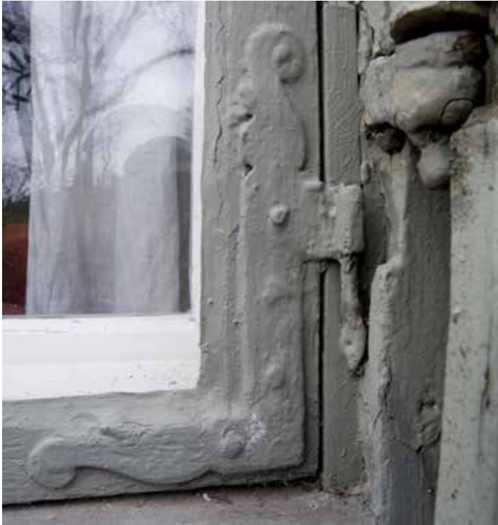
FÖNSTRENS HÖRNBESLAG ÄR TILL HUVUDELEN AV 1700- OCH 1800-TALSTYP. ÄVEN SENTIDA PRESSADE HÖRNBESLAG FÖREKOMMER. BILDEN VISAR ETT DEKORATIVT HÖRNBESLAG AV 1700-TALSTYP. FOTO. J MALMBERG.
