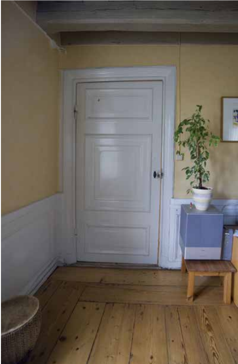
INTERIÖR MED BRÄDGLV, PANEL OCH BJÄLKTAK FRÅN 1700-TALET. DÖRREN ÄR AV HELFRANSK TYP MED KAMMARLÅS OCH TRE FYLLNINGAR, DEN MITTERSTA FYLLNINGEN HAR RUNDADA HÖRN. FOTO. J MALMBERG
