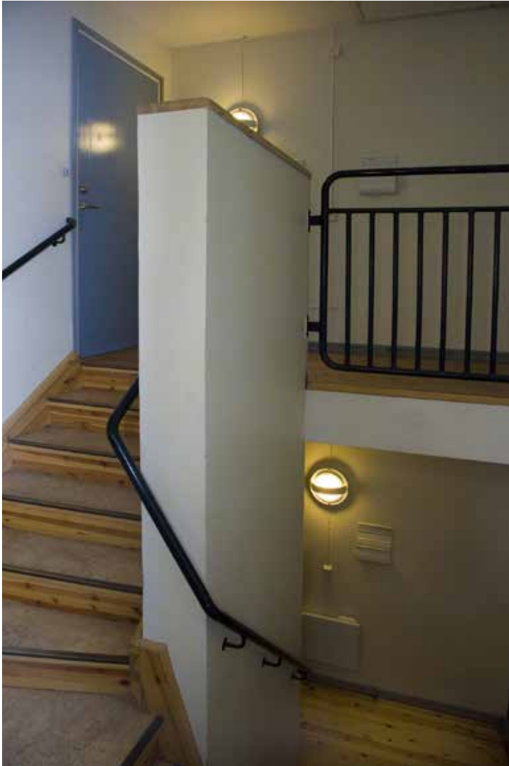
TRAPPHUSET I DEN LÄGRE SÖDRA BYGGNADSKROPPEN INREDDDES UNDER 1990-TALET. FOTO: J. MALMBERG
