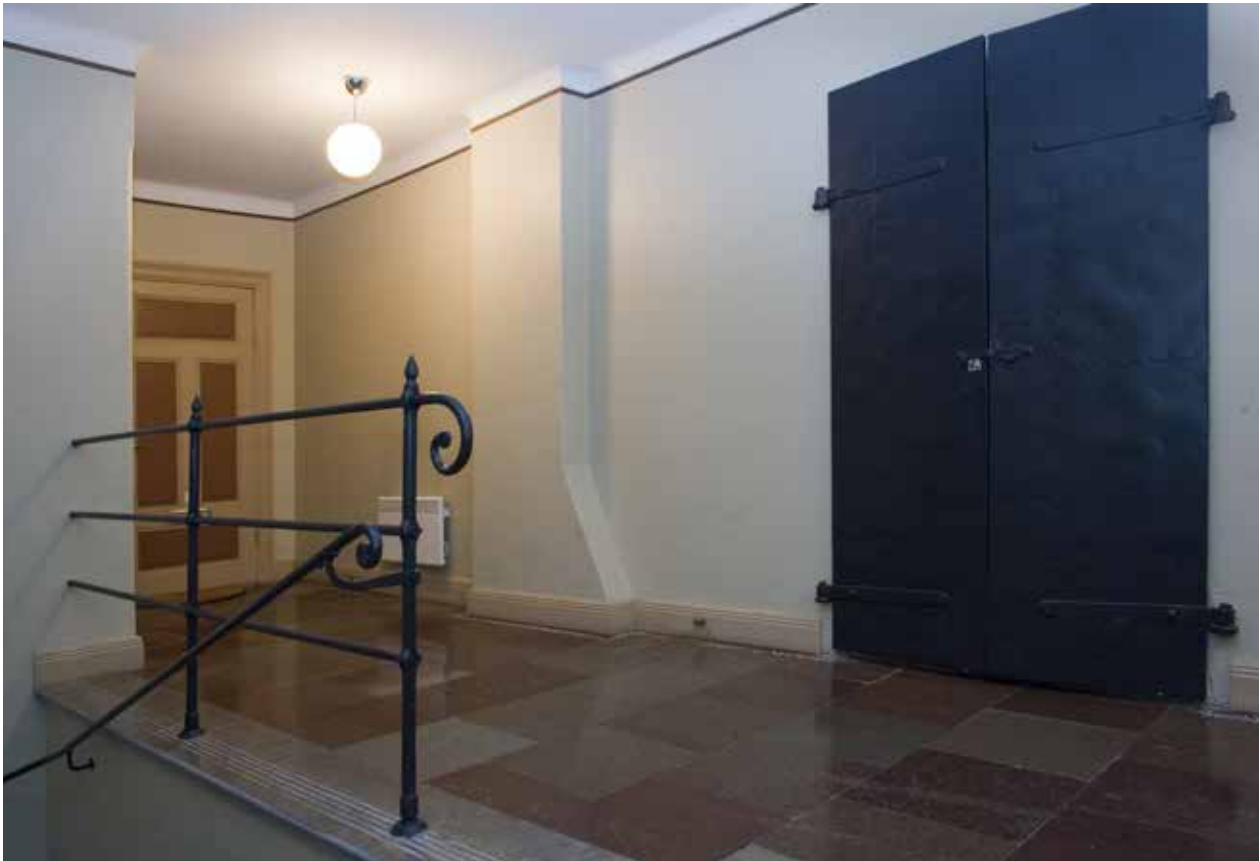
I TRAPPHUSET FINNS ÄLDRE KALKSTENSGOLV, RÄCKE AV GJUTJÄRN SAMT Fyllningsdörr och Järndörr. FOTO: J. MALMBERG
