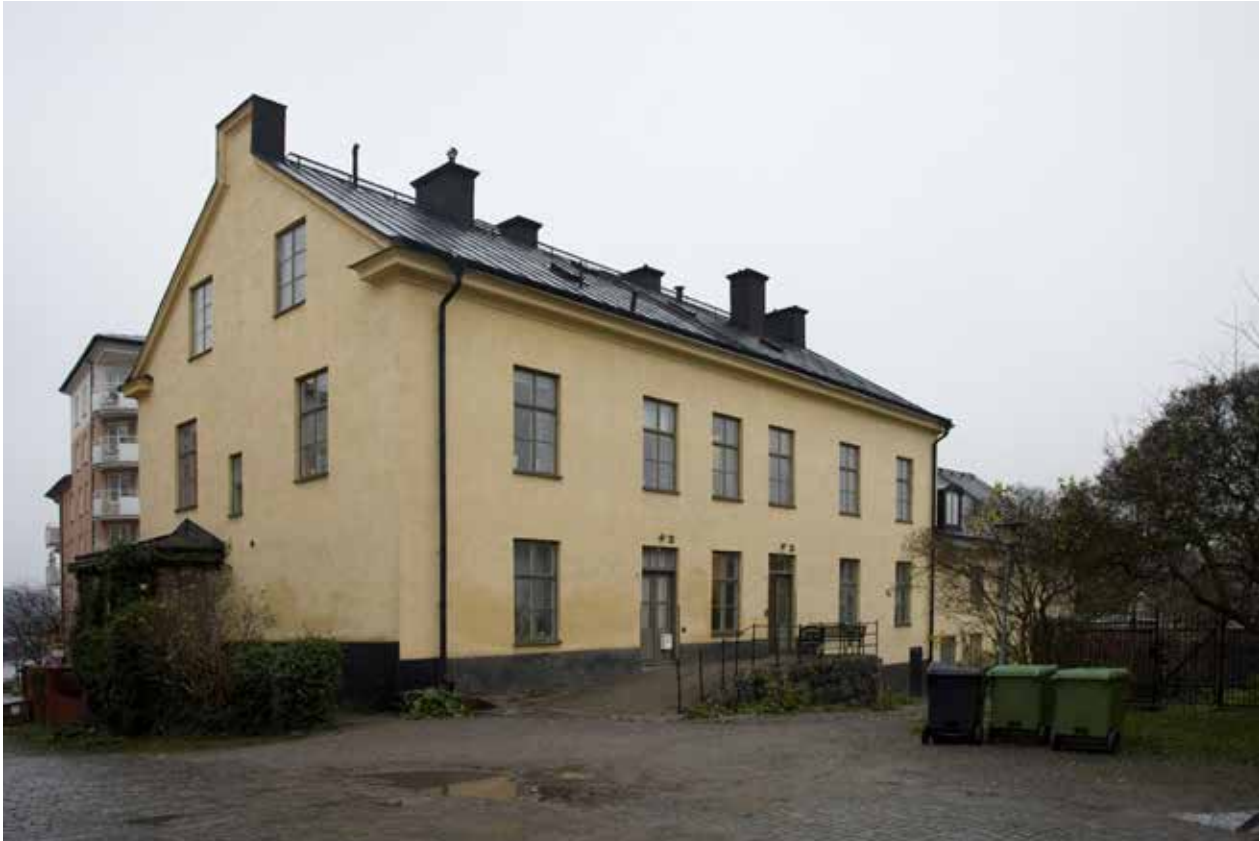
BYGGNADEN BESTÅR AV TVÅ TYDLIGT URSKILJBARA HUSKROPPAR. DESS NORRA GAVEL HAR ETT KARAKTERISTISKT GAVELKRÖN OCH VERANDA. FOTO: J. MALMBERG
