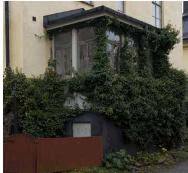
GLASVERANDA PÅ DEN NORRA FASADEN. FOTO: J. MALMBERG
