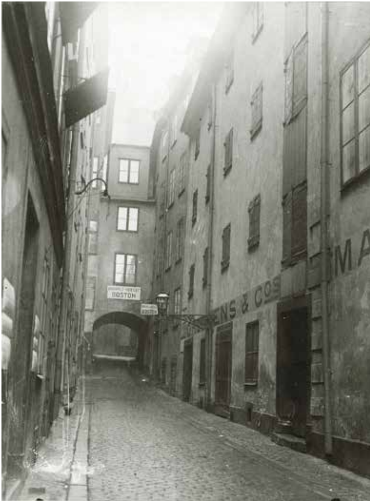
GRÄNDÖVERBYGGNADEN SEDD FRÅN ÖSTER, MED EN SKYLTVÄRRETT FÖR HOTELLET BOSTON OVANFÖR PORTEN, TILL HÖGER OM VALVET. FOTO: A. MALMSTRÖM, CA 1930. STADSMUSEETS ARKIV, F 9000.
