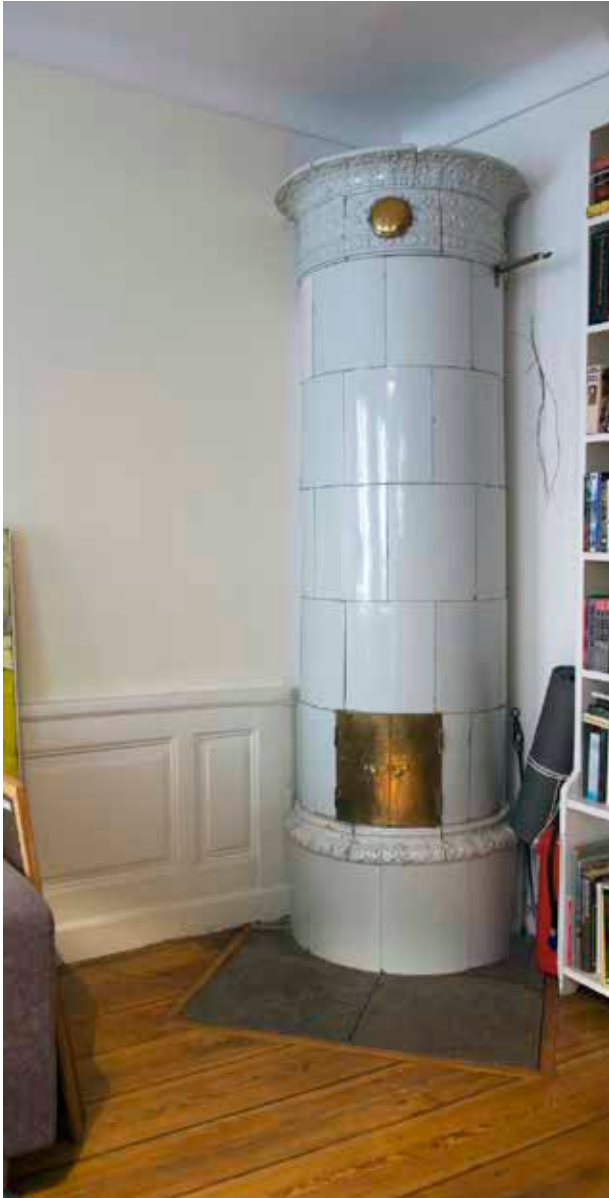
KAKELUGN FRÅN 1800-TALETS ANDRA HÄLFT, OCH BRÖSTPANEL FRÅN 1840-TAL. FOTO: J. MALMBERG.
