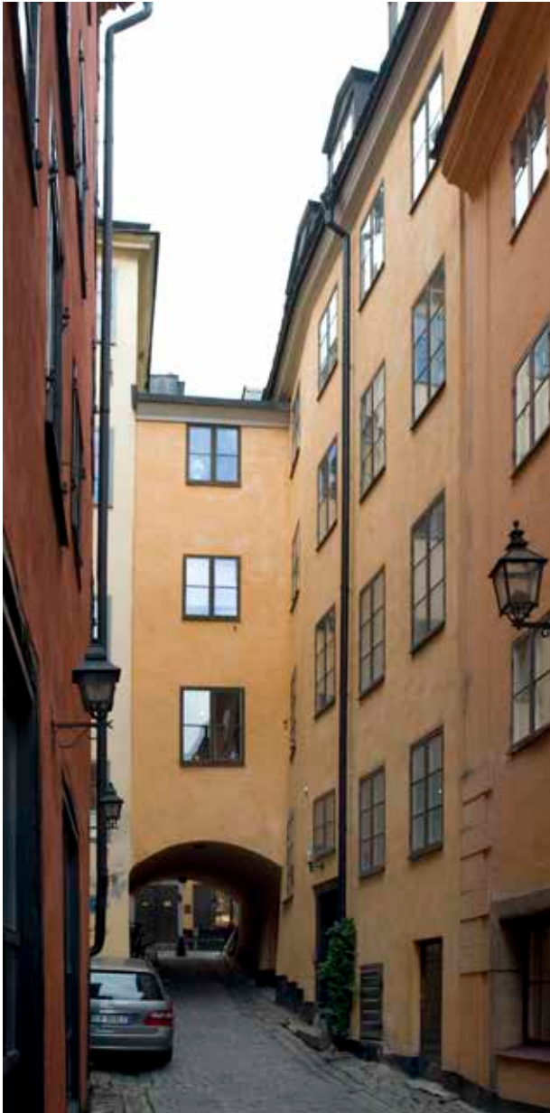
FASTIGHETENS EXTERIÖR SKILJER SIG INTE MYCKET FRÅN 1930, MEN DEN HORISONTELLA LISTEN NEDANFÖR DEN INREDDA VINDEN I VALVÖVERBYGGNADEN ÄR BORTA. FOTO: J. MALMBERG.
