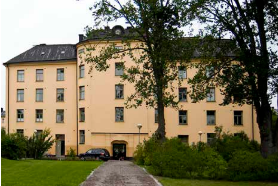
SÖDRA BOSTADSHUSETS FASAD MOT SÖDER. FOTO: J. MALMBERG.
