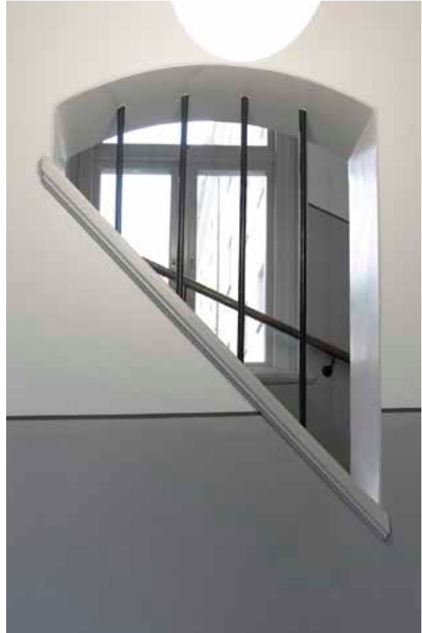
TRAPPHUSEN MED JÄRNGALLERFÖRSEDDA ÖPPNINGAR I TRAPP- SPINDELMUREN. SÖDRA BOSTADSHUSET. FOTO: J. MALMBERG.
